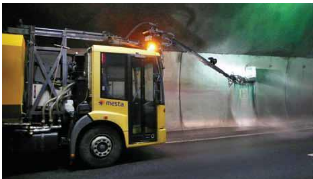
Figur 1: Rengjøring av Nøstvettunnelen (E6, Akershus) i 2011 (Foto: Kjersti Wike Kronvall).
