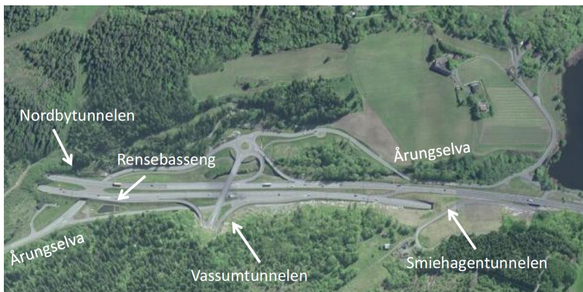
Figur 34: Bilde ble hentet fra Meland 2012. Det er et oversiktsbilde over E6 (Frogn kommune, Akershus) med sedimenteringsbasseng og omkringliggende tunneler. Sedimenteringsbassenget mottar vaskevann fra tre tunneler (Nordby-, Vassum- og Smiehagentunnelen) samt avrenningsvann fra vegarealet i mellom tunnelene. Etter rensprosessen blir vaske- og avrenningsvann drenert ut i Årungselsva. Innsjøen Årungen ligger til høyre i bildet.
