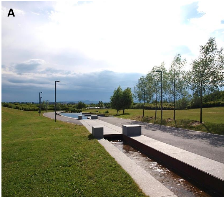
Bilde 7: Viser hovedkanalen som sørger for sirkulasjon i vannmassene i Nansendammen. Bilde A viser øvre del av kanalen der vannrennen møter vannkanalen, mens bilde B viser utløpet fra vannkanalen til øvre basseng i Nansendammen.
