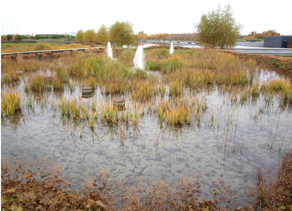
Bilde 23: Viser bakkant av filterflaten i Biofilter 3 hvor det enda ikke er etablert vegetasjon. Bilde er tatt i uke 42.
