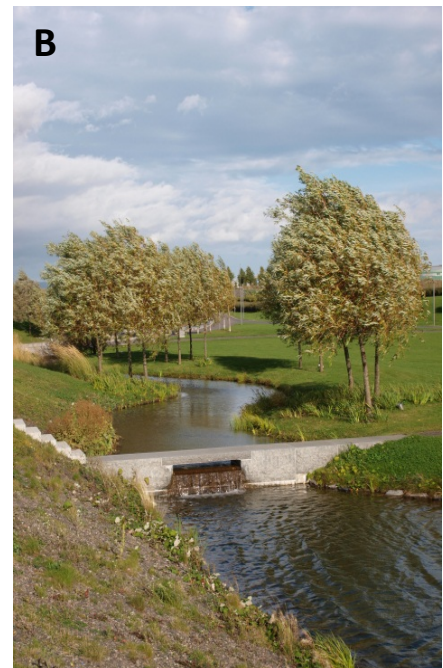
Bilde 7: Viser hovedkanalen som sørger for sirkulasjon i vannmassene i Nansendammen. Bilde A viser øvre del av kanalen der vannrennen møter vannkanalen, mens bilde B viser utløpet fra vannkanalen til øvre basseng i Nansendammen.
