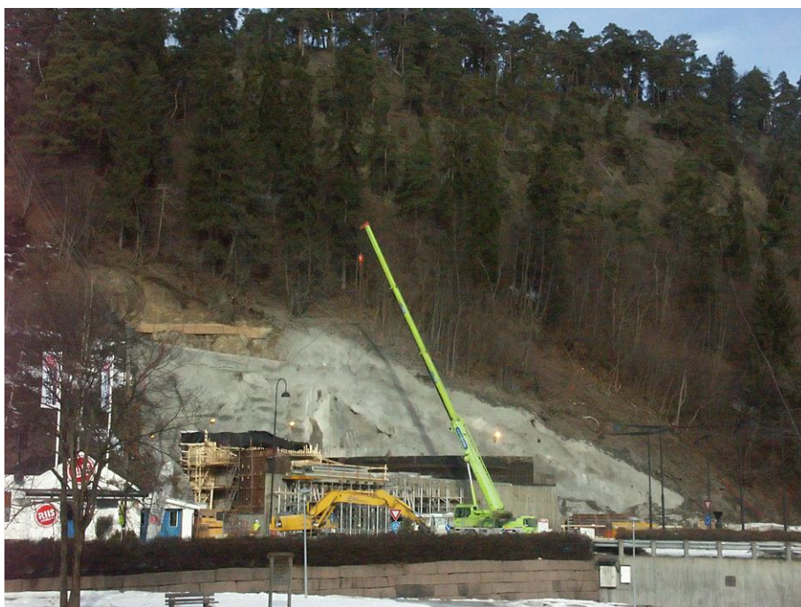
Figur 73: Anleggsområde anno mars 2012. Betong er sprøytet langs åssiden og stålkonstruksjonen danner forarbeid til et kommende tunell løp i betong ut mot rundkjøringen.
