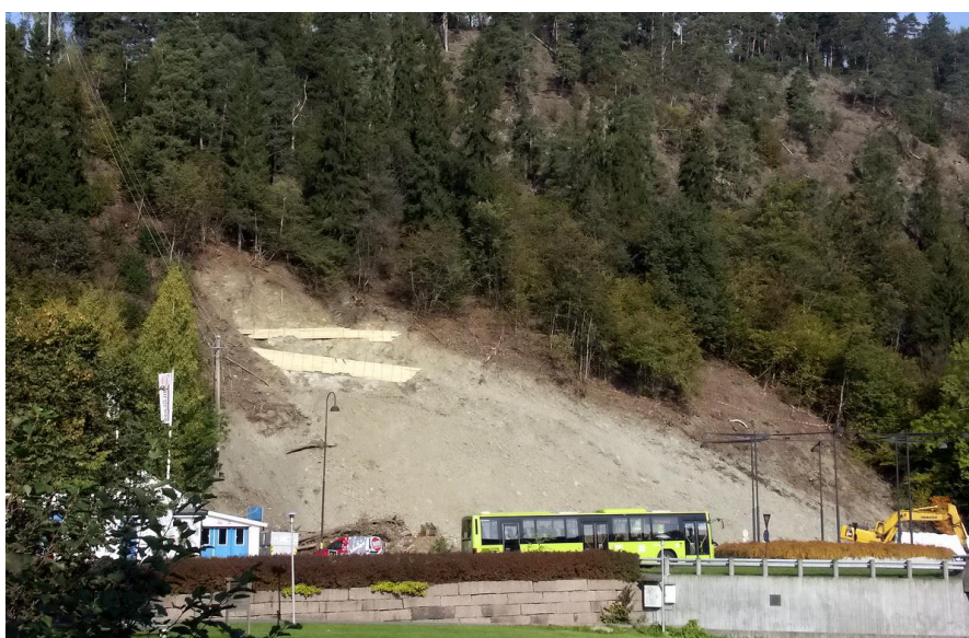
Figur 29: Anleggsområdet 29/9 - 11 etter at fjell er funnet. Trekonstruksjonene i overkant av området er sognemurer som skal sikre anleggsområdet for utrasing.
