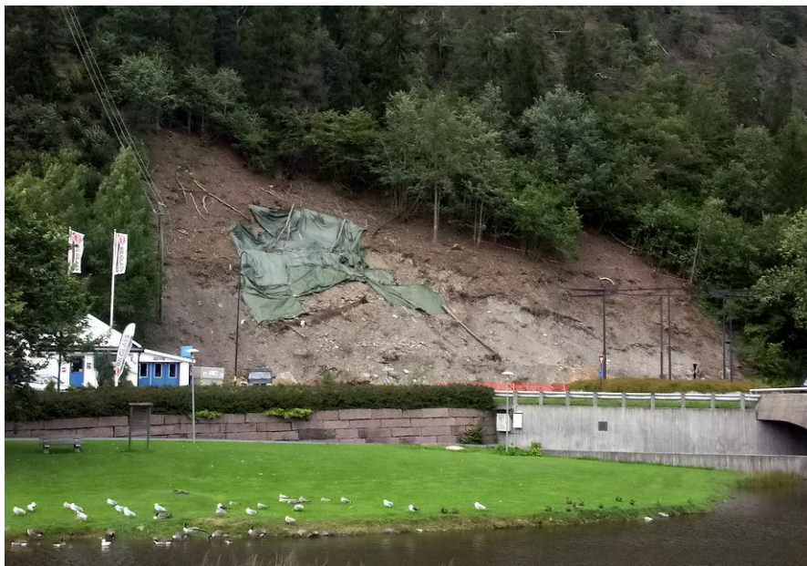
Figur 28: Anleggsområde den 28/8 - 11. På figur 26 sto gravmaskinen hvor presenningen ligger på dette bilde.
