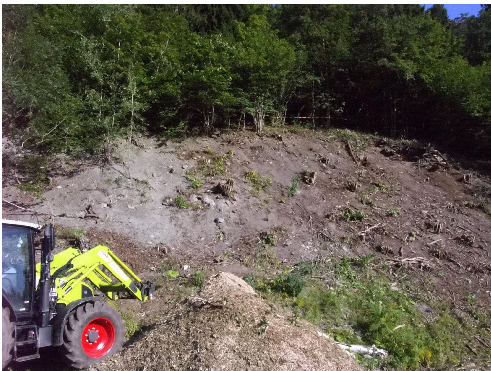
Figur 25: Masser 29/7 med oppkuttet flis der jorden i veikantsonen enda ikke er fjernet.
