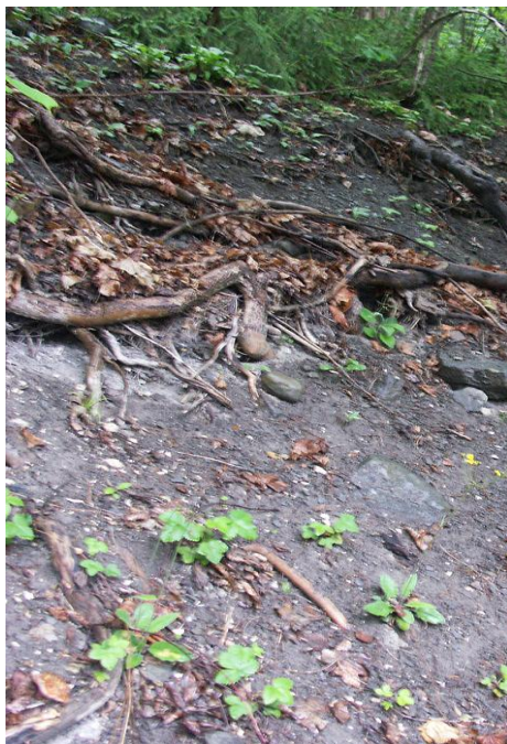
Figur 35: Skråningen bak Riis bilglass med mye åpen jord og lite stabiliserende vegetasjon
