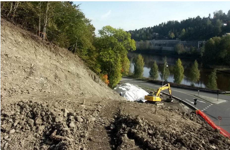
Figur 31: Lagret toppjord i veikantsonen ved Engervannsveien.
