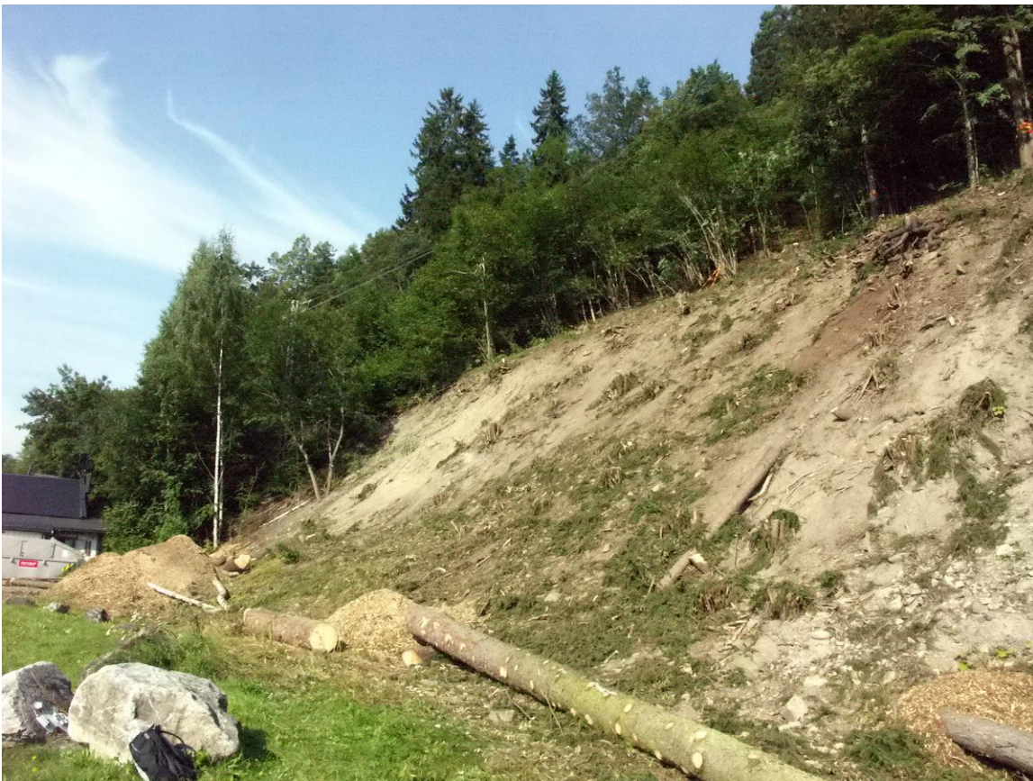
Figur 24: Kapping mot vest 2/8 - 11 fulgte markeringsbåndet som planlagt.
