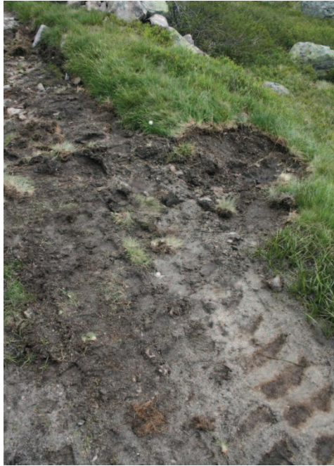
Figur 44. Det er hentet ut jord fra intakt vegetasjon langs slepa, og jorda er lagt midt i et kjørespor.
