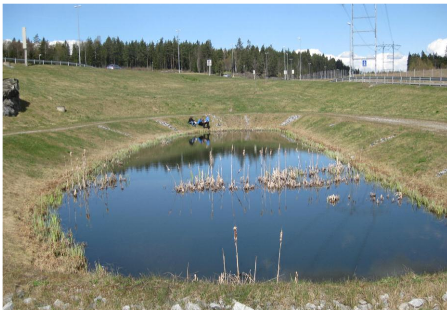
Figur 18. Rensebassenget Taraldrud sør, mai 2010. Slambassenget vises i forgrunnen.
