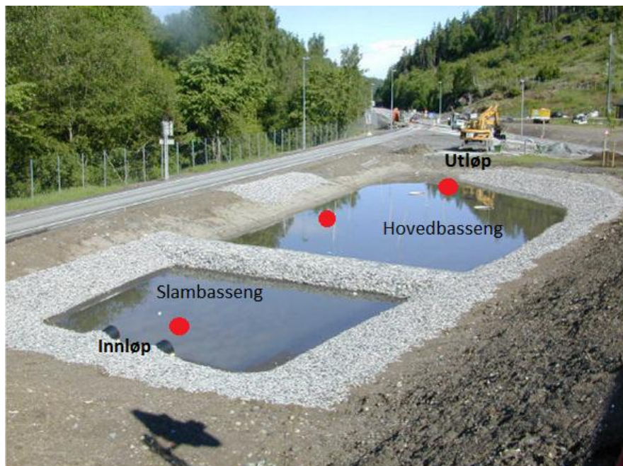
Figur 20. Foto av rensebassenget i Vassum før oppfylling med vann. Røde punkter markerer prøvepunkter. Foto: R.Roseth (Snilsberg et al. 2002).
