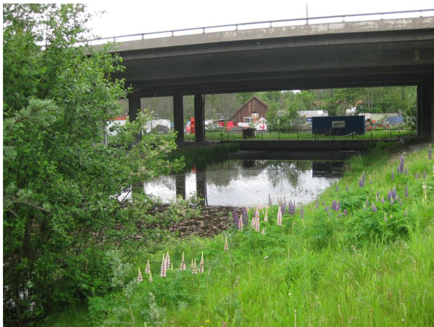
Figur 9. Foto av deler av hovedbassenget til renseanlegget i Skullerudkrysset, mai 2010.
