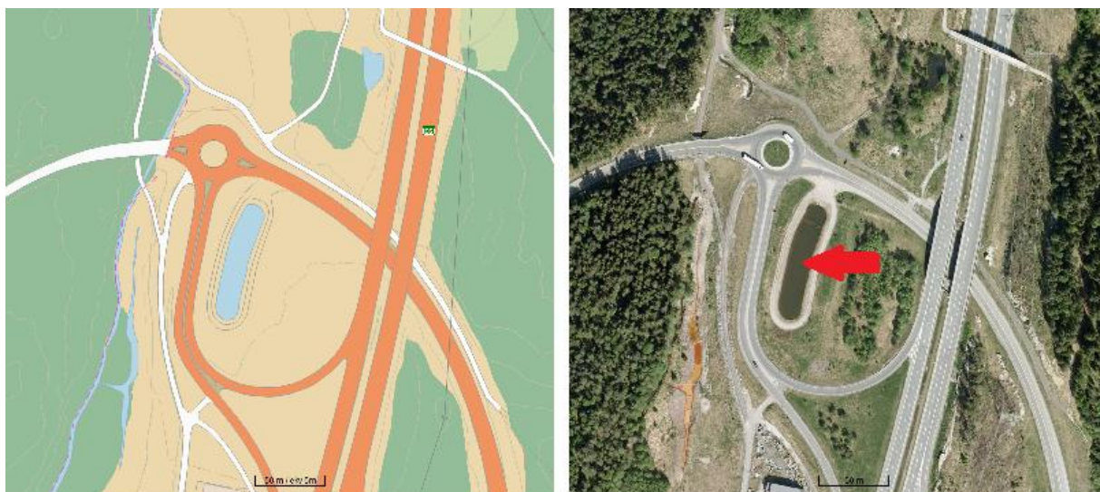
Figur 13. Kart og flyfoto over Taraldrudkrysset. Rød pil viser rensbassenget.
