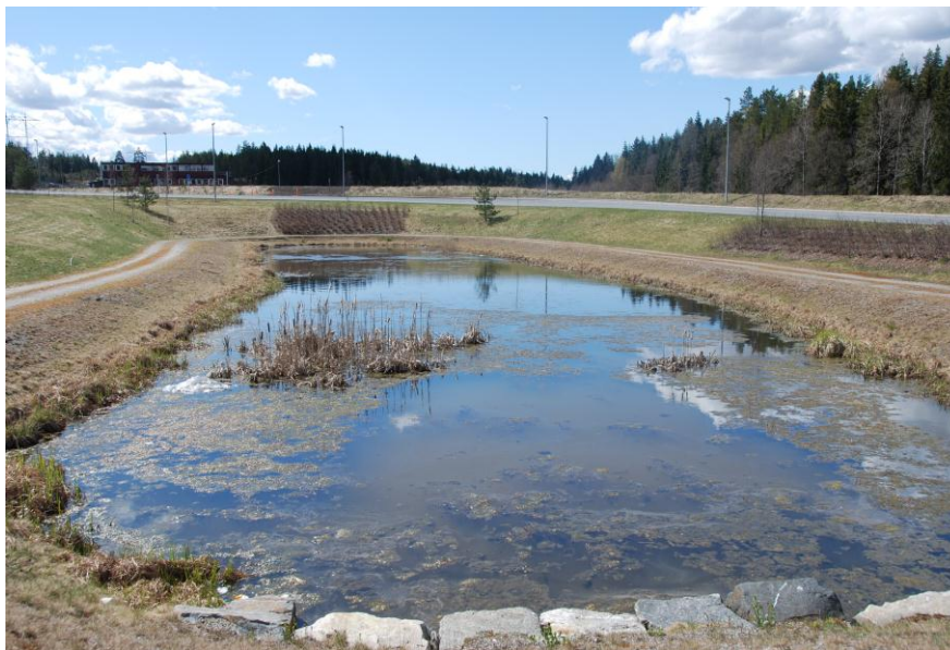
Figur 15. Rensebassenget i Taraldrudkrysset, mai 2010. Slambassenget er i forgrunnen. Foto: L.S.Heier.
