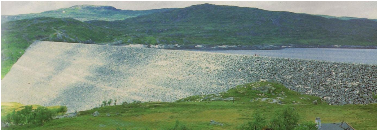
Fig 3.1-12: Masseuttakene på Dyranut og Byen ble brukt i forbindelse med byggingen av Sysendammen. Foto av Hillestad (1988).
