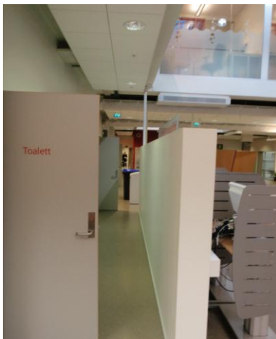
Figur 15; foran toalettene har man bygget en halvvegg som danner en smal korridor foran toalettene.
