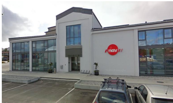
Figur 4; forside av bygget med trapp og rampeløp.
