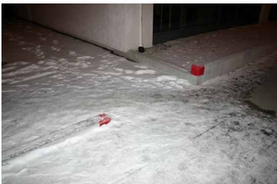
Figur 5;passasje fra HC-parkering til rampeløp. Passasjebredden er her 1,5 meter.
