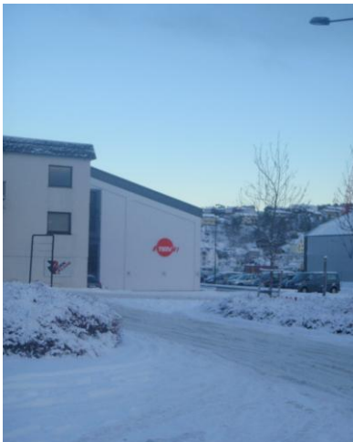
Figur 3; byggets sørende, sett fra atkomstvei til bygget.
