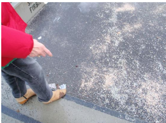
Figur 29; nederste trinnet på trapp går i ett med asfalten i bunn av trappen grunnet fargevalg på trappenesen.
