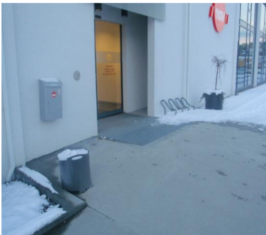
Figur 11; nisje foran dobbel elektrisk skyvedør. På bildet ses askebeger og sykkelstativ utenfor hovedinngangen.
