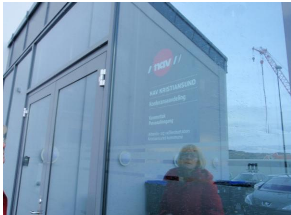
Figur 35; informasjonen som er plassert bak de speilende glassflatene er knapt synlig for en normaltsende person.
