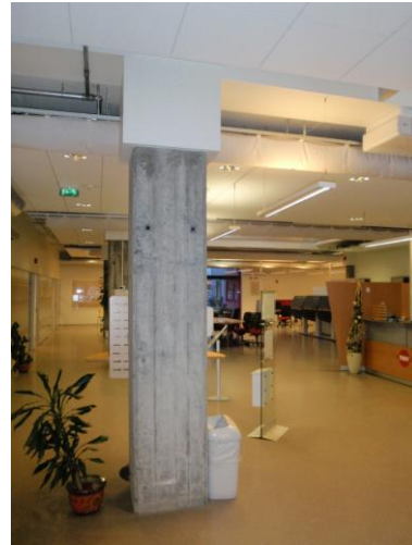
Figur 14; det er fire frittstående betongsøyler i publikumsmottaket. Ingen av disse er merket.
