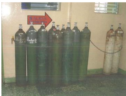
Figur 29: Gasstanker bør sikres for tregheitskrefter for å unngå velting.
