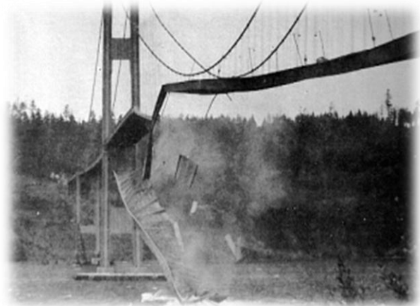
Figur 10: Tacoma Bridge kollapse etter resonans fra vinden. (Kilde: http://mvscu.blog.com/ )
