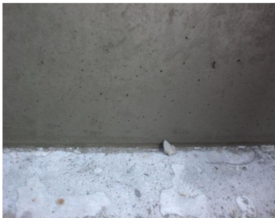
Figur B.3: God fylling - lavkarbonbetong [1]
