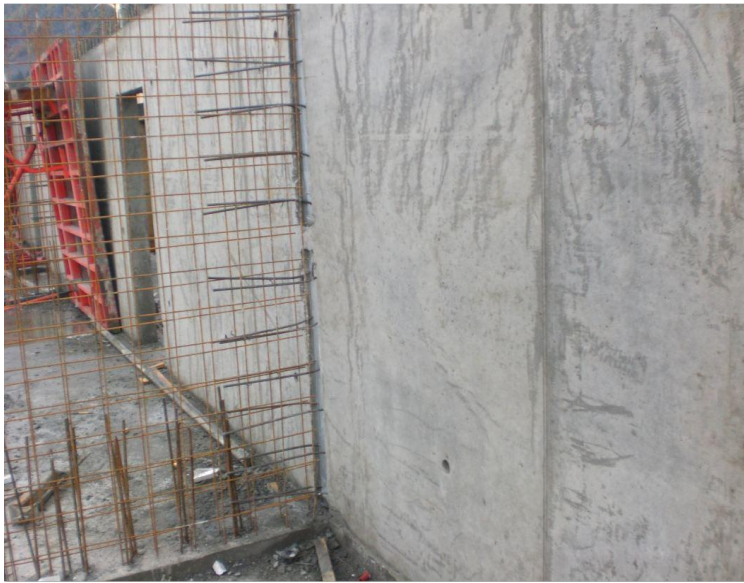
Figur B.1: Overflate - lavkarbonbetong [1]
