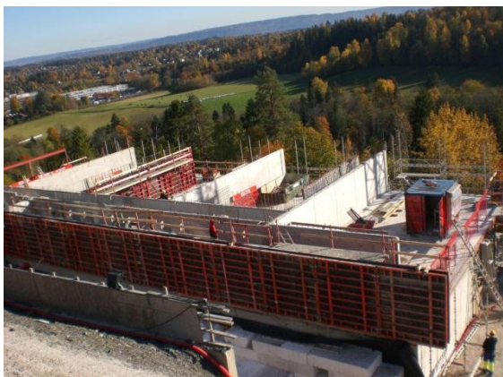
Figur 4.1: Andre etasje med lavkarbonsement, blokk B, Åstadryggen [1]
