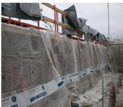
Figur 5.4: Tildekking med duk for innføring av varm luft under duken [1]
