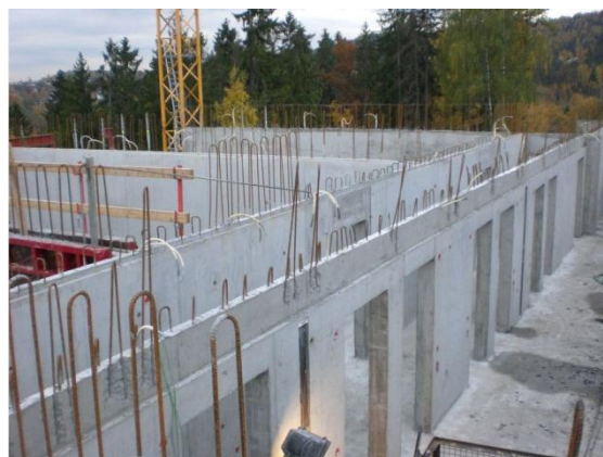
Figur 4.2: Andre etasje med lavkarbonsement, blokk B, Åstadryggen [1]
