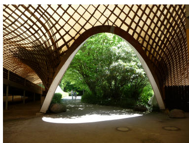
(a) Inngangsparti med kryssfinerplater
