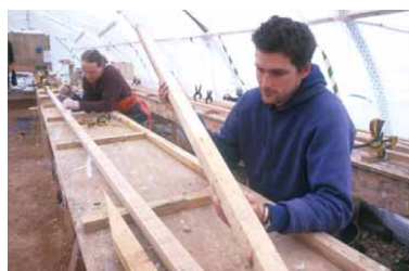
(b) Gjæring på byggeplassen
