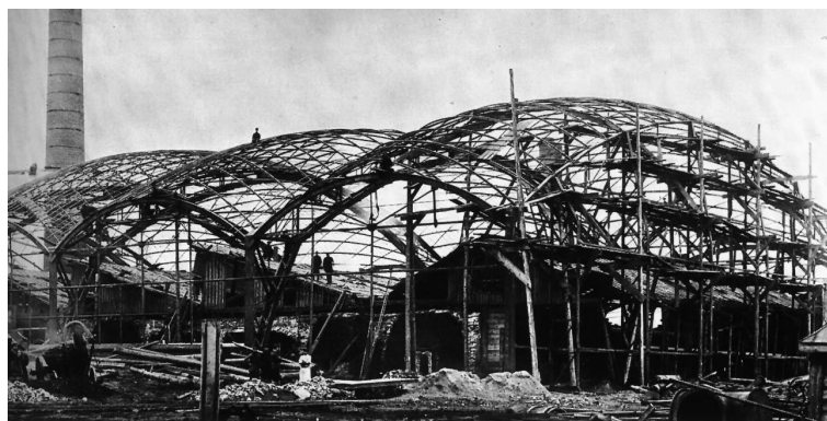
Figur 5.10: Oppføring av Sjukovs gitterskall i stål i Vyksa, 1897 (Wikimedia Commons)
