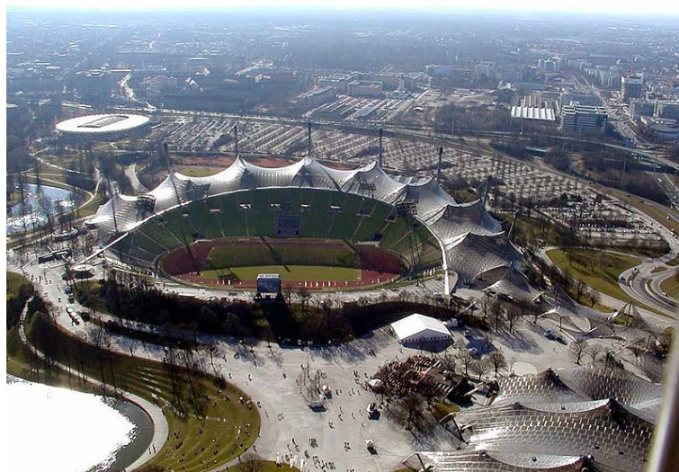
Figur 5.12: Teltformet kabelkonstruksjon. Olympiastadion, Munchen (Wikimedia Commons)
