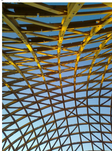
(d) Vanlig konstruksjonstre og ingen liming (Foto: Alessadro Cirillo)
