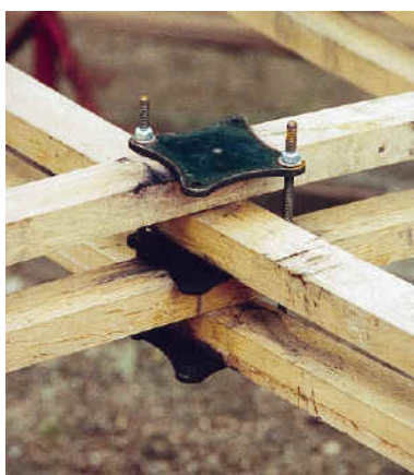
Figur 5.21: Spesialutformede forbindelsesmidler (Foto: Wealddown.co.uk )
