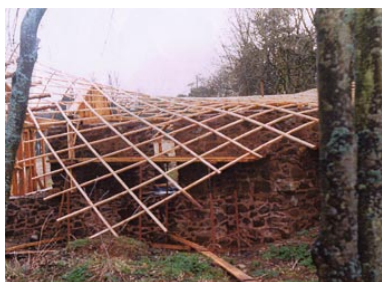
(a) gitteret løftes på plass
