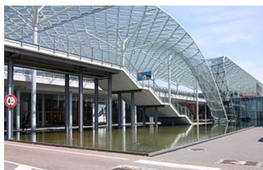
(a) La Fiera di Milano av M. Fuksas (Wiki- media Commons)
