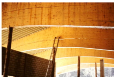
Figur 5.8: Tverrstrekk i buet limtrebjelke [5]
