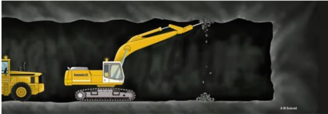
Figur 11. Rensk av tunneltak med renskerigg.[24]
