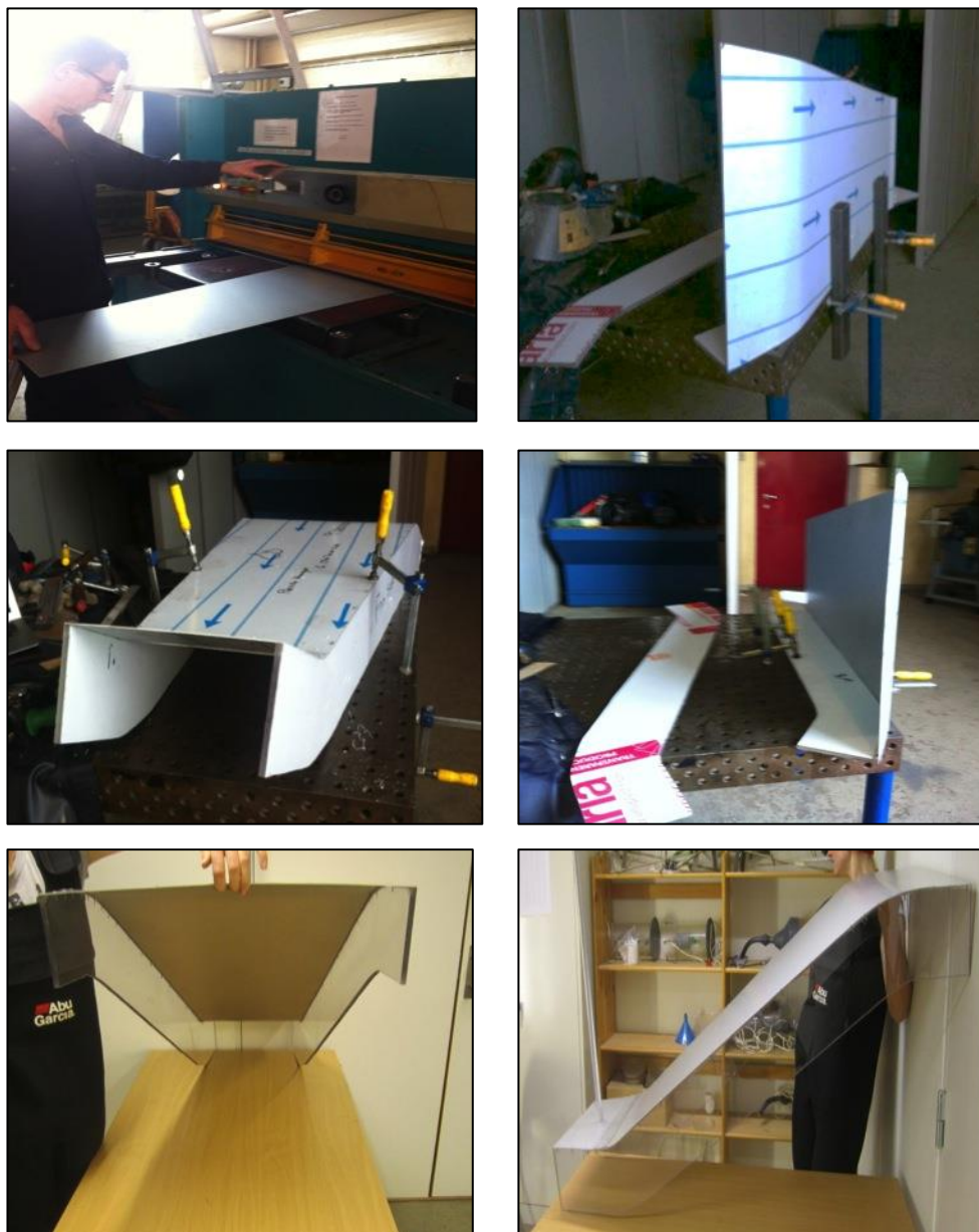
Figur 45: Konstruksjon av prototype. Kapping, montering og sluttprodukt (foto: eget)
