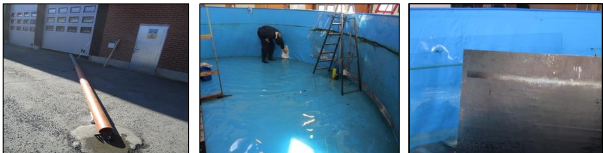
Figur 66: Opprydningsarbeid. Tømming og vask av bassenget (foto: eget)
