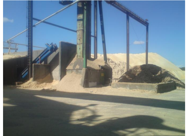
Figur 11 Til høyre ligger lager for råspan. I midten ligger elevator som frakter råspan videre til råspan- og kutterflismølle.
