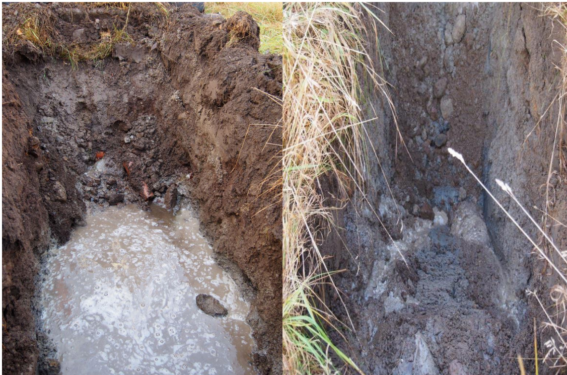
Figur 39 og 40: Sjakt 1 og sjakt 2
