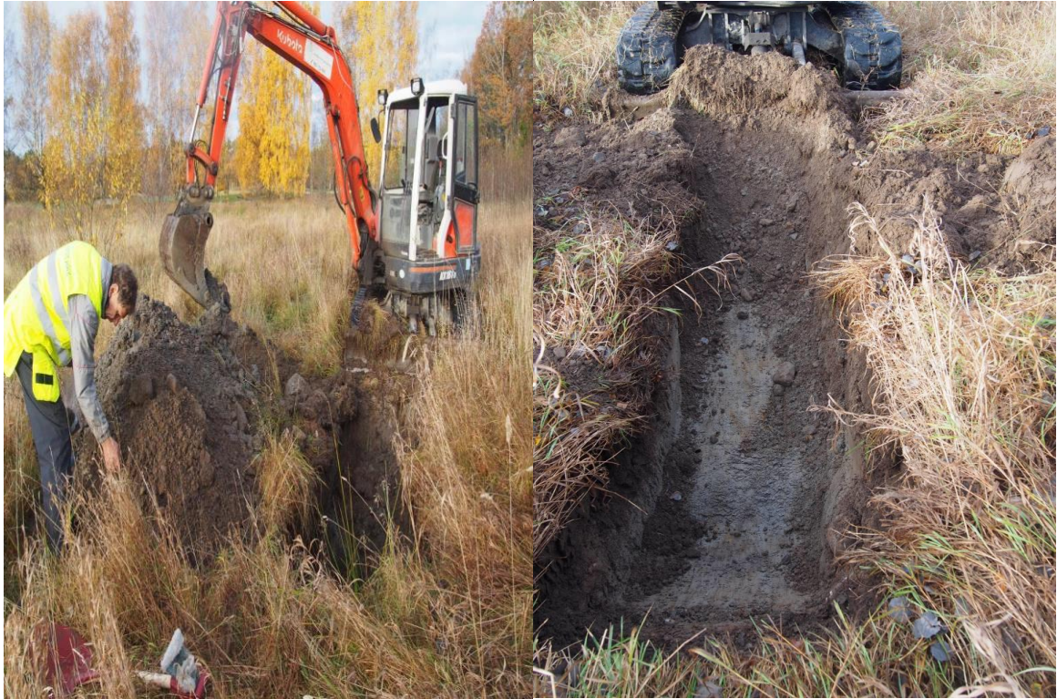
Figur 41 og 42: Sjakt 3 og sjakt 4
