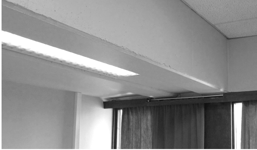
Figur 5 Doble betongdragere gjennom klasserom 147
