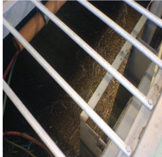
Figur 4. Bygget der biologisk rensing pågår. Figur 5. Bioreaktor med biomedie.
