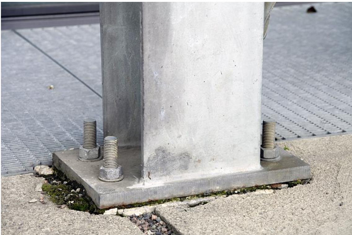
Figur 8: Detaljbilde av nærmeste søylefot på forsidebildet.
