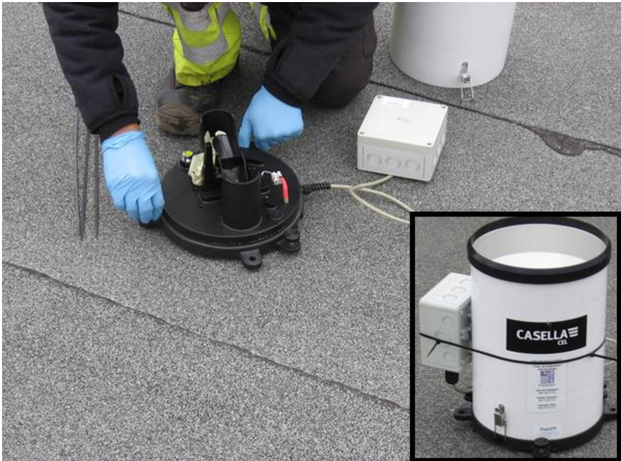
Figur 5.4.5. Installering av mobil nedbørsmåler av typen Casella 100000E på takflate Nordre Aker skole i Oslo (Foto: Christopher Strauman)
