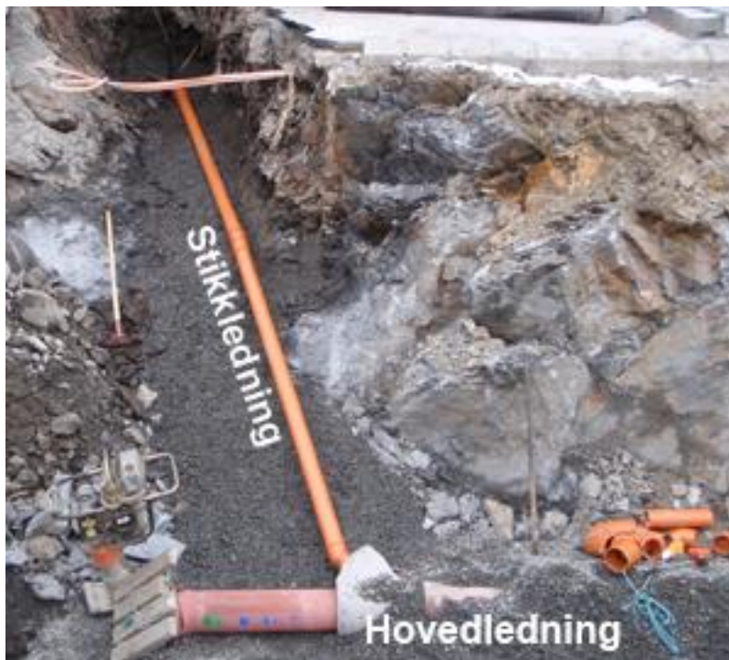
Figur 7.2.2. Anboring av stikkledning på kommunal hovedledning (Stavanger kommune 2013)
