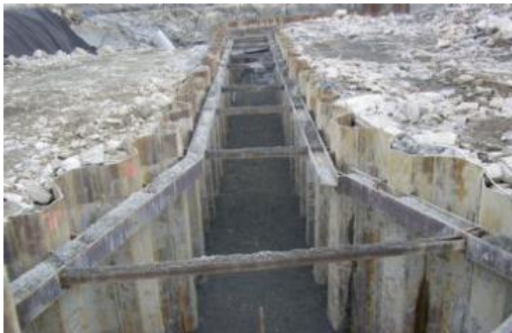
Figur 16: Grøft med spunting og avstivning i topp (Stangeland maskin, 2013)
