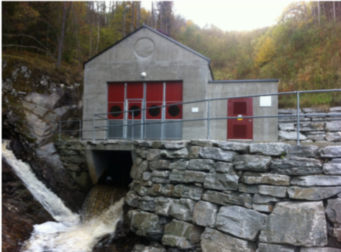
Figur 2: Fotografi av Rekåa kraftverk 6. oktober 2013. Turbinen og generatoren er plassert i hoveddelen til venstre på bildet. Transformatoren befinner seg i høyre del av bygget. Foto: Guro Aase.
