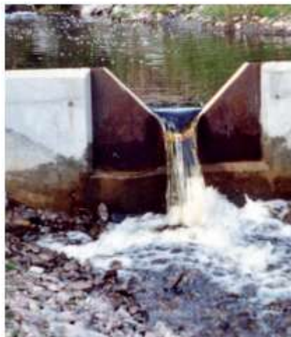
Figur 23: V-overløp med horisontale overløp (Endresen 2006).
