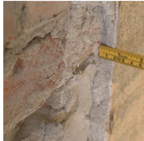
Figur 29 Innvendig puss (MWB)
