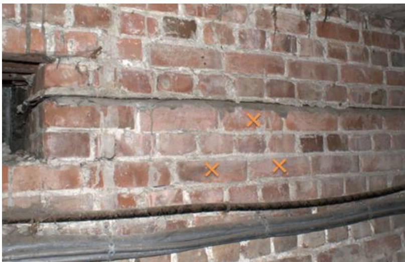
Figur 17 Bildet viser de tre steinene som ble tatt ut. (MWB)
