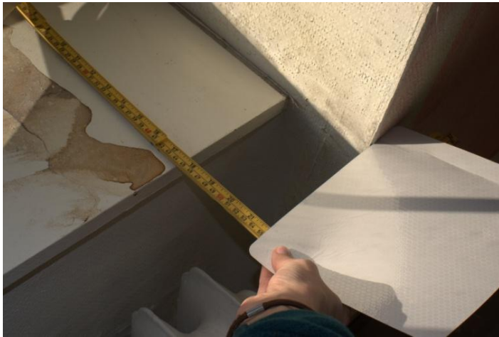
Figur 28 Oppmåling av vegg 2. etasje (MWB)
