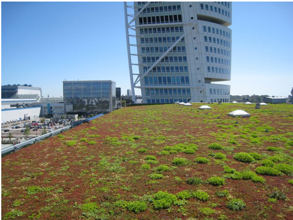
Figure 5: Sedumtak på et næringsbygg Malmö (Vegtech 2012).
