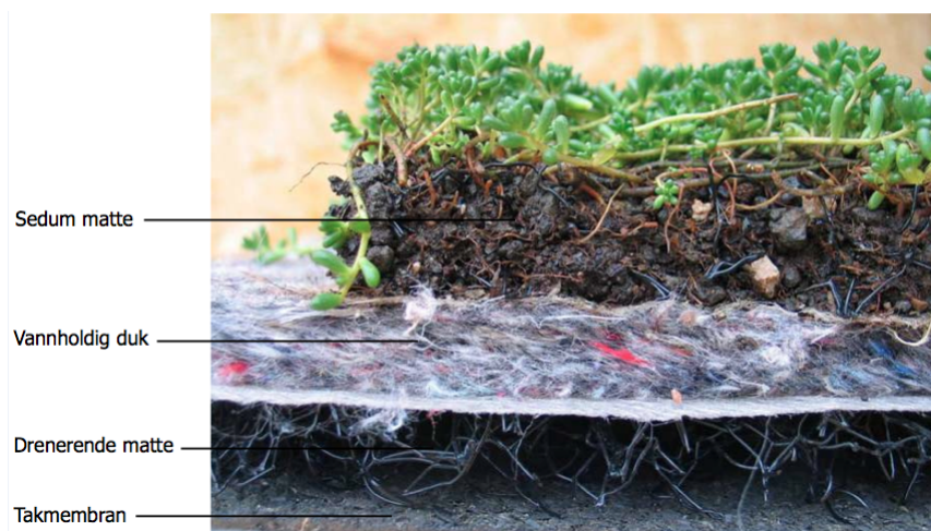
Figure 6: Oppbygning av sedumtak (Vegtech 2012).
