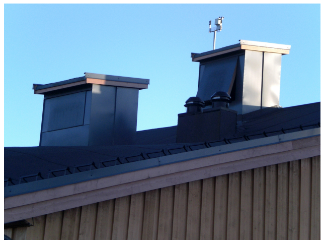
Bilde 13: Avtrekkshette på tak (Foto: Hans Magnus Jelsnes)
