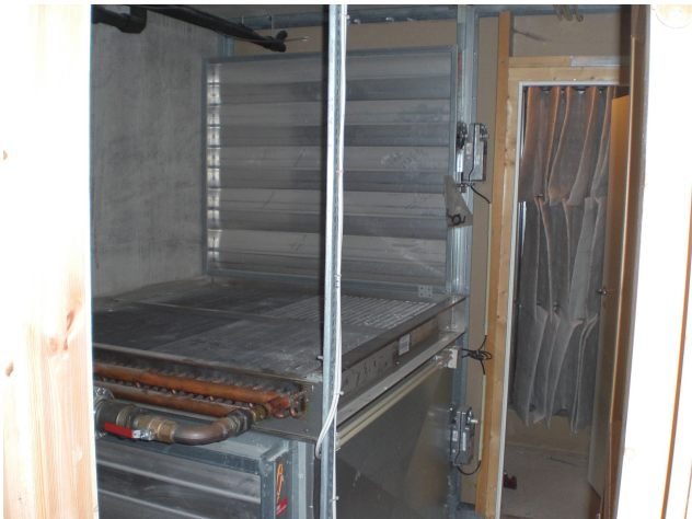
Bilde 6: Varmebatteri i luftfrvarmingsrom. Filtervegg i bakgrunn (Foto: Hans Magnus Jelsnes)
