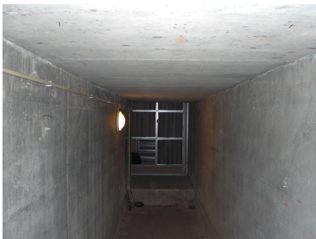
Bilde 5: Inntakskulvert med filtervegg og måler i bakgrunn (Foto: Hans Magnus Jelsnes)
