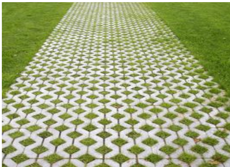
Figur 33: Eksempel på permeable dekker, her er det gressarmering.
