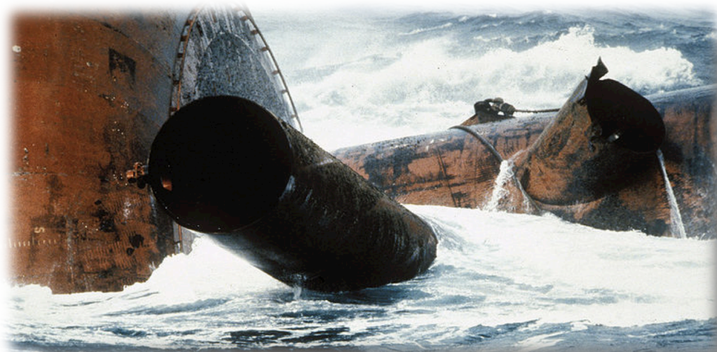
Figur 1: Bildet viser hvor utmattingsbruddet skjedde på Aleksander Kielland plattformen i 1980. Denne ulykken er å regne som en av de største og mest fatale i Norges historie der 123 mennesker omkom [3].
