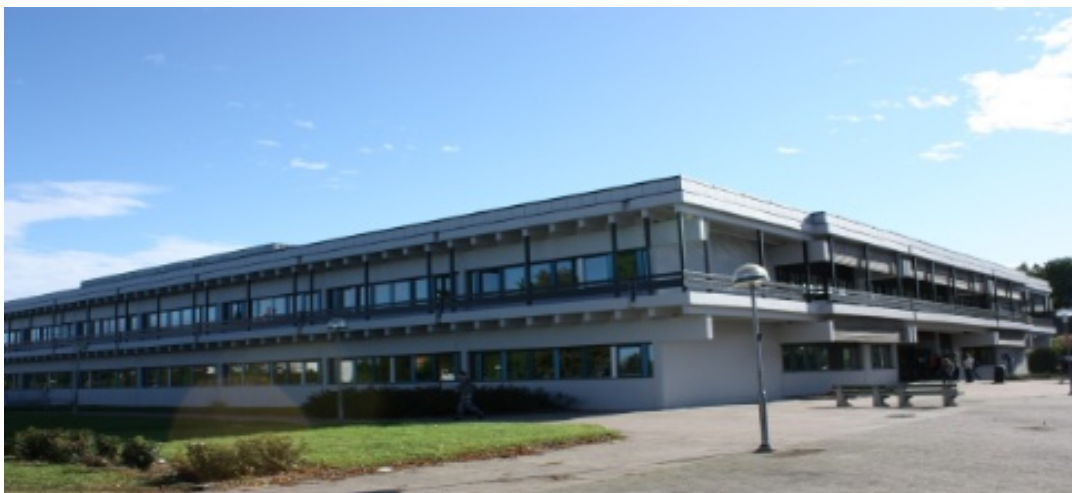
Figur 4.1 St. Olav videregående skole (St. Olav VGS, 2013)
