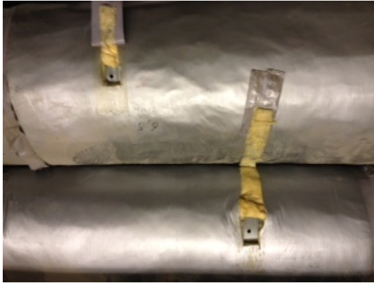
Figur 3.5 Traversingshull ventilasjonskanaler
