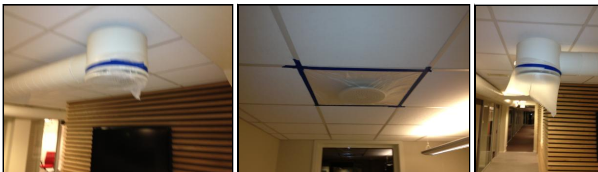
Figur 10: Tetting av ventilasjon i kontorlokalet (bilde til venstre og midten skaper viften undertrykk, mens det skapes overtrykk på bildet til høyre)
