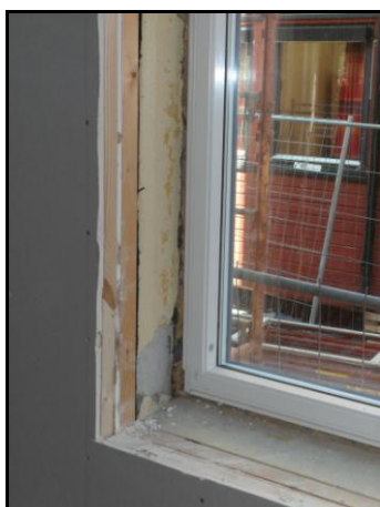
Figur 23: Montering av vinduer i eksisterende del (bilde av Mats C.J.S.)
