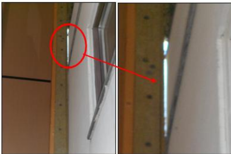
Figur 20: Åpning i overgangen mellom eksisterende bygning og påbygget (bilde av Mats C.J.S.)
