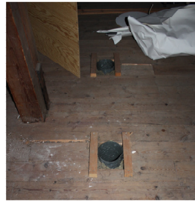
Figur 25: avtreks ventiler utmot kaldtloft
