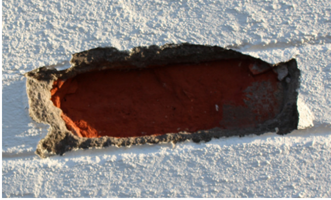
Figur 29: Av skalling på grunn av frostskaadet
