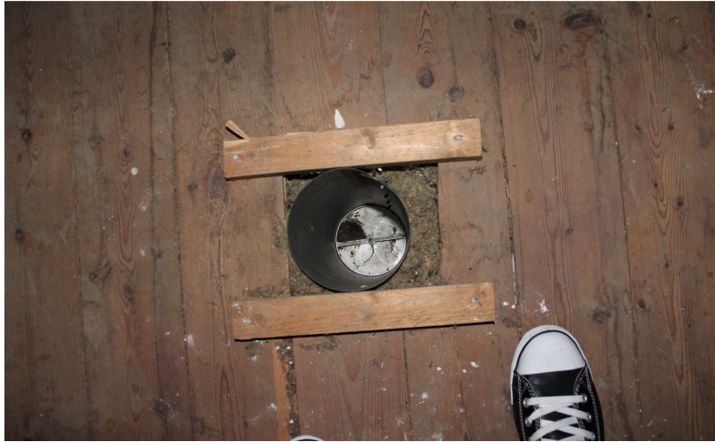
Figur 27: Bilde tatt fra kaldloft over audetorium (ref: fotografert av Waqas Afzal)
