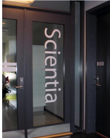
Figur 11: Stor skrift som markering på glassdør
