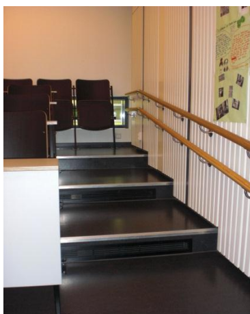
Figur 17: Tydelige trinn i og håndlist i to høyder.
