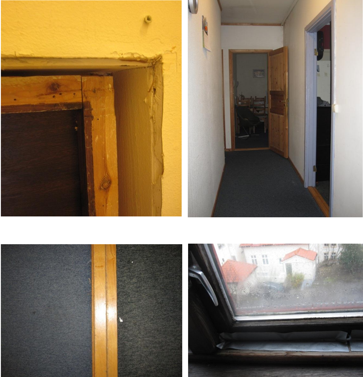
Bilde 13: Øverst til venstre: Overgang dør/karm/vegg. Øverst til høyre: Trang, lang gang. Nederst til venstre: Gulv-til-gulv-teppe. Nederst til høyre: Arkvindu over vernet fasade med ducttape som tetting Foto: Ida Bergløykken
