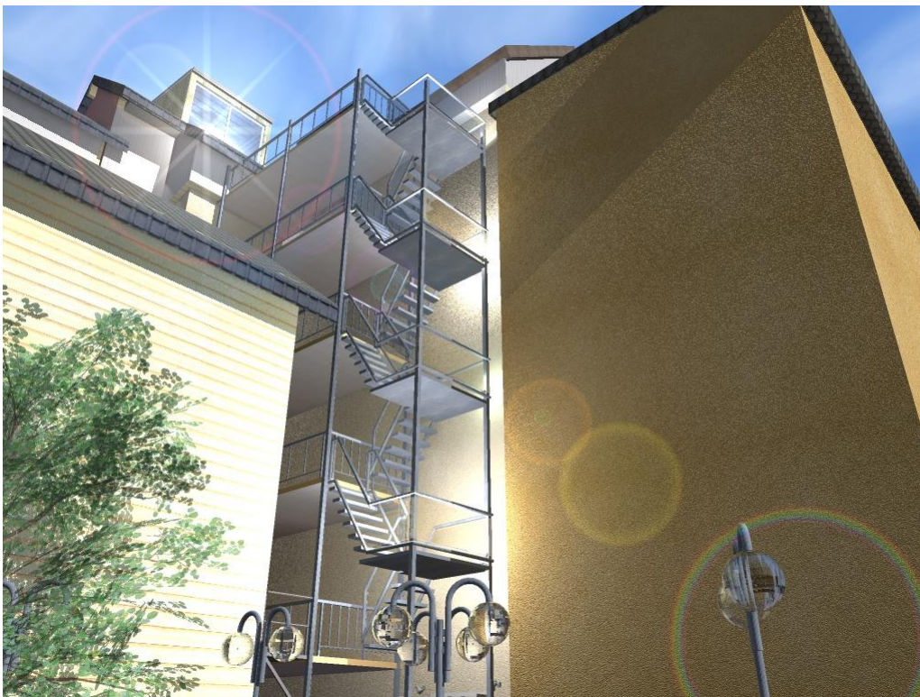
Bilde 20: Utvendig branntrapp ut mot bakgården sikrer beboerne. Illustrasjon: Ida Bergsløkken.
