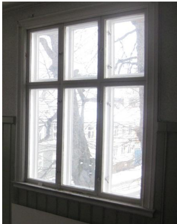
Figur 30. Vinduene har enkelt glass i utvendig ramme og enkelt glass i innvendig varevindu (Bilde fra befaring til Trondheim, februar 2011).
