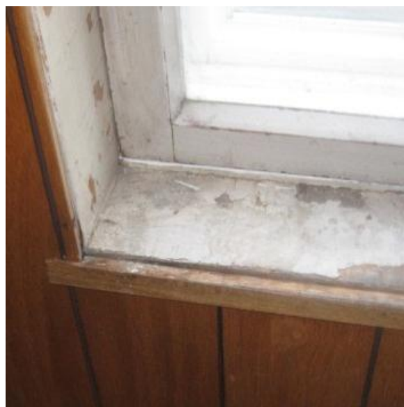
Figur 31. Knust glass. Slitasje på karm og ramme (Bilde fra befaring til Trondheim, februar 2011).
