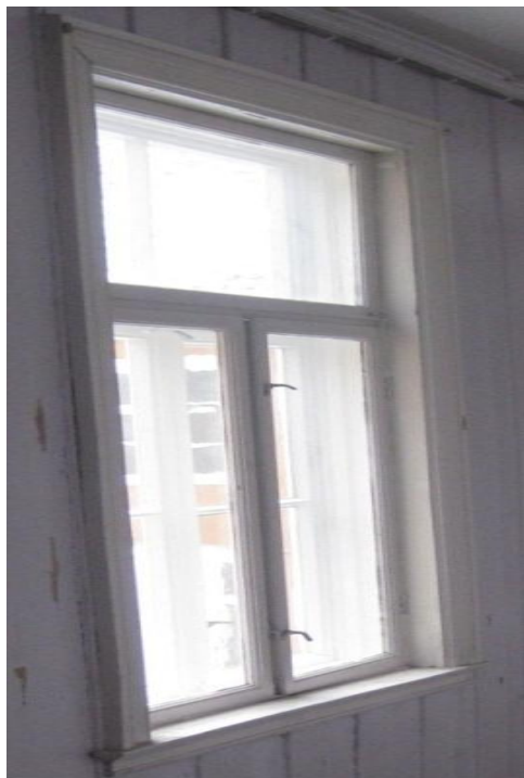
Figur 30. Vinduene har enkelt glass i utvendig ramme og enkelt glass i innvendig varevindu (Bilde fra befaring til Trondheim, februar 2011).
