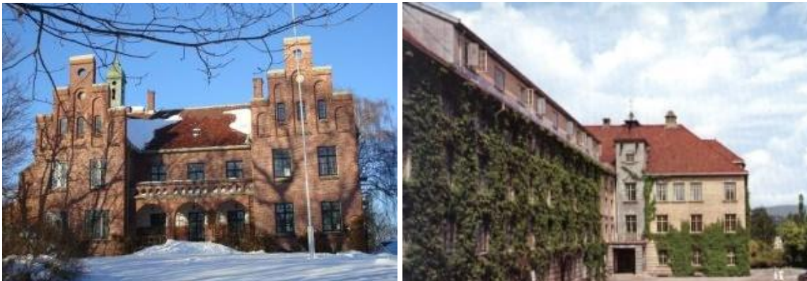
Figur 21. Ringstabekk husstellæreskole. T.v. «Slottet». T.h. hovedbygningen (Moe 2009).
