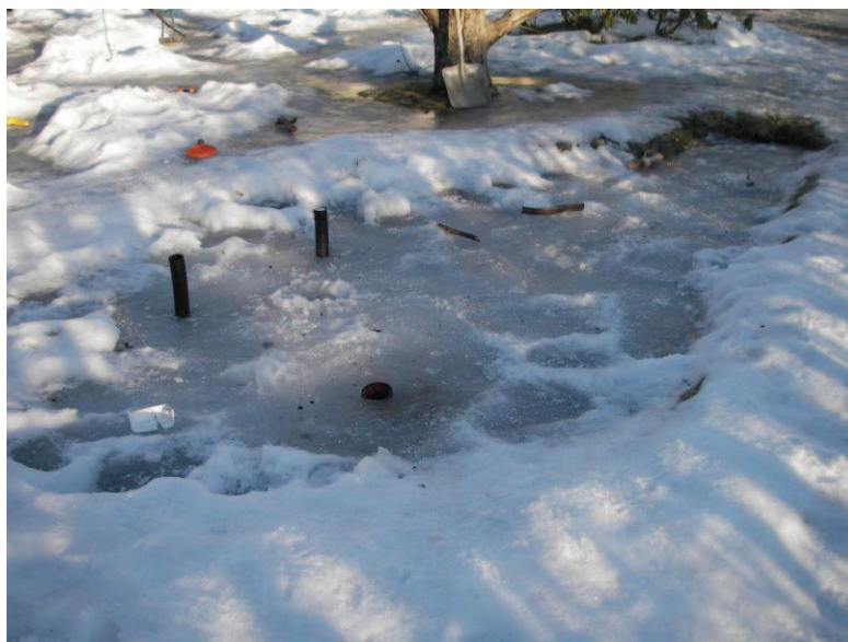
Figur 61. Isdannelse i regnbedet i NB21, 14 dager etter simulering med syntetisk nedbør 21.02.12. Foto: Bent C. Braskerud
