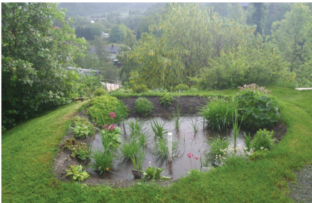
Figur 8. Regnbed under nedbørhendelse i Melhus kommune. Foto: Rolf Arne Grande
