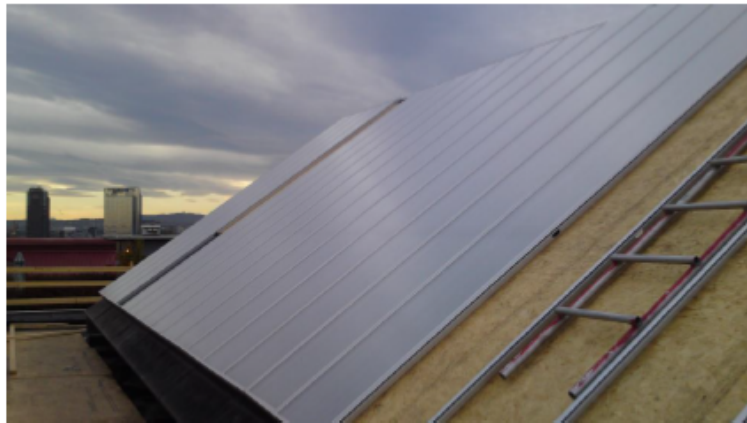
Montering av solfanger på takoppbygg
