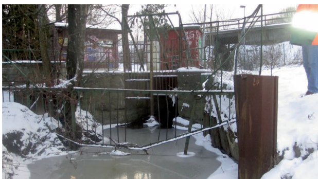
Figur 72: Viser et bilde fra Veumbekken ved overgang fra åpen bekk til kulvert. (Foto: Torbjørn Lothe Vik 2012)
