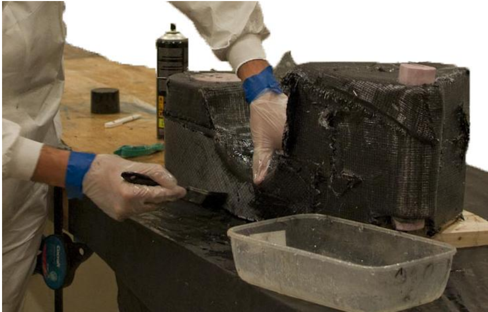
Figur 74:[27]. Viser pålegging av karbonfiber duk, hvor epoxyen pålegges med pensel.
