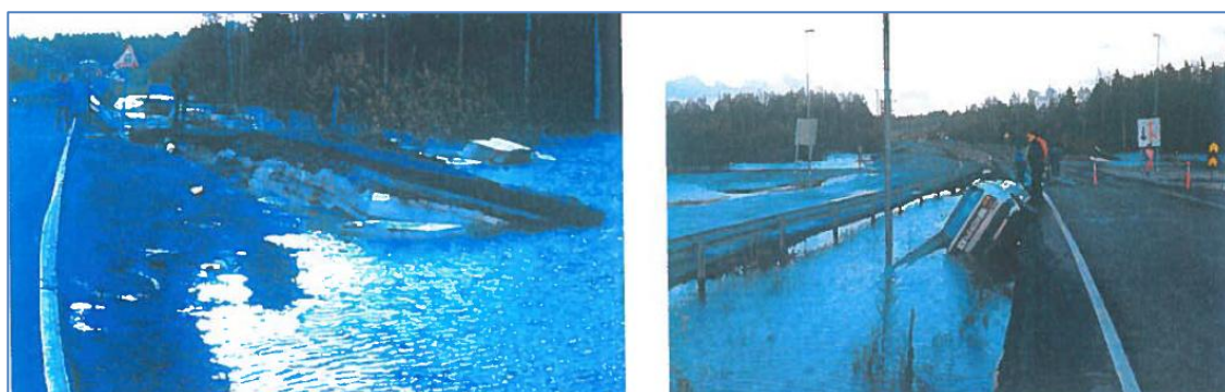
Figur 3.4 T.v.: EPS-blokker tyter opp. T.h.: Vannet hever vegfylling på rv. 159 sør for Lillestrøm (Ref.9).
