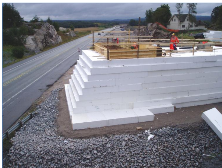
Figur 10.14 Gimsøyveien bro, en midlertidig bro fundamentert direkte på EPS, stod over E6 i Halden kommune (Ref.33).
