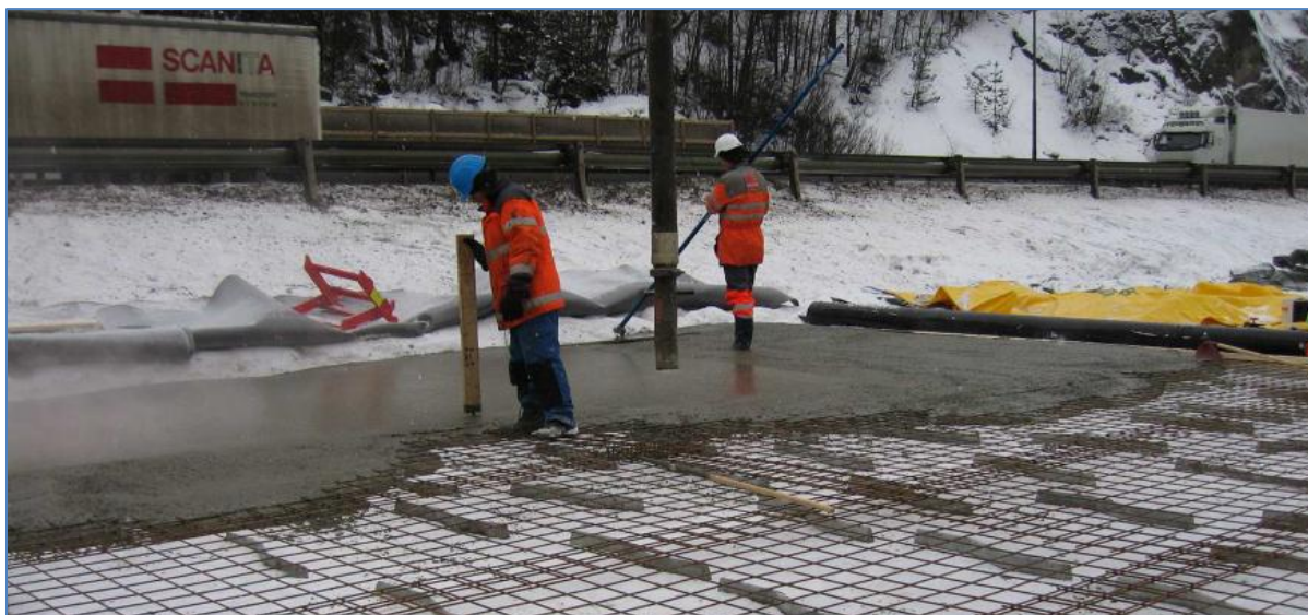
Figur 4.7 For beskyttelse mot bla. løsemidler og for å få en god lastfordeling, støpes det et armert betongdekke direkte oppå EPS-fyllingen. En betongplate med en tykkelse på 10 cm vil ha en lastfordelingkoeffisient på 3,0 som er tre ganger som større som for et tilsvarende tykt grusdekke (Ref. 20).
