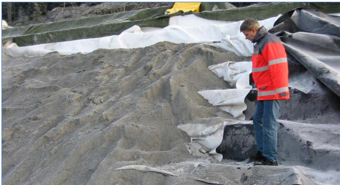
Figur 4.6 Sideskråningen av EPS-fyllingen er dekket av membran (den svarte plastfolien) som følger blokkenes overflate. Membranen er tett for å beskytte skumplasten fra eventuelle løsemidler som bensin. Over membranen ligger en fiberduk som skal beskytte membranen. Over membranen og fiberduken ligger en overdekning av steinfri masse, med minimum 25 cm dybde (Ref.2). Bilde: (Ref. 20)
