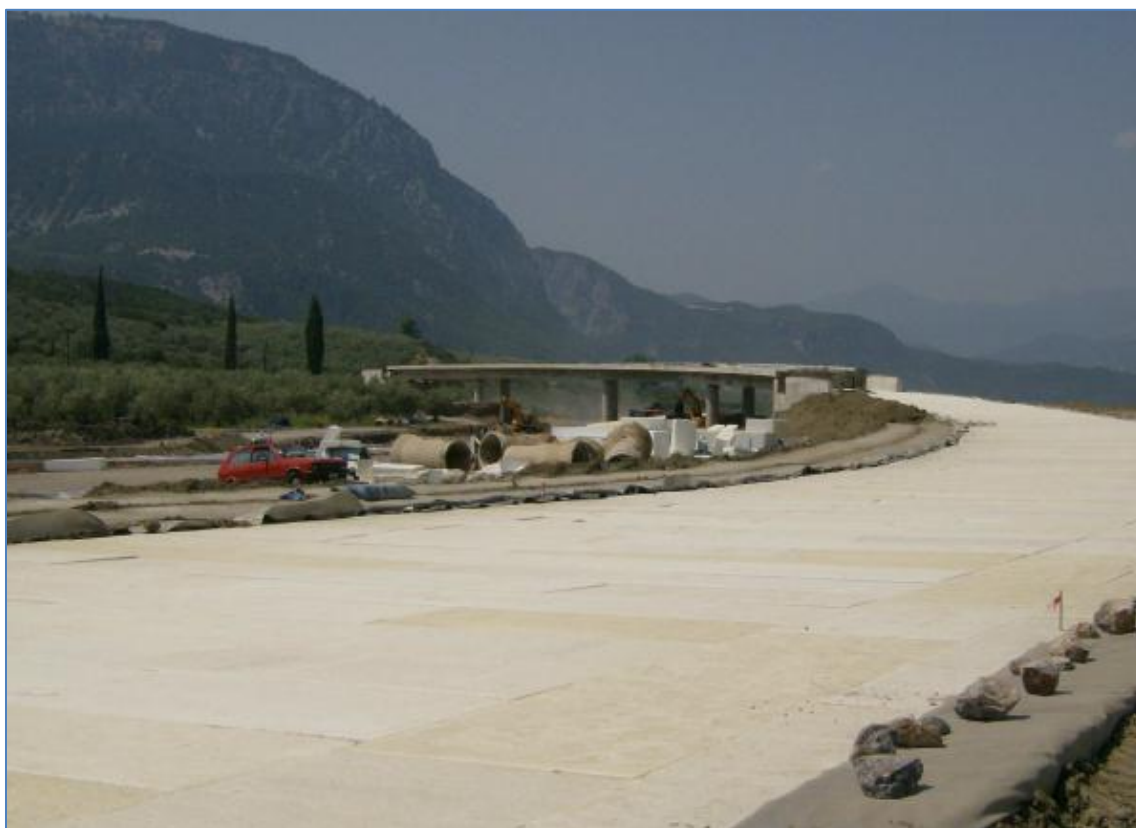
Figur 6.8 En 65 000 m 3 stor EPS-fylling i Hellas. (Ref.35).
