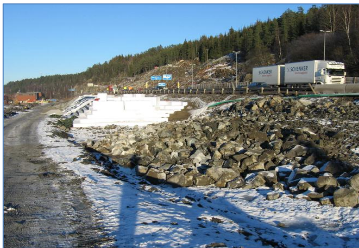
Figur 5.3 Bilde fra byggetiden på E6/E18 Vinterbro (Ref. 20).
