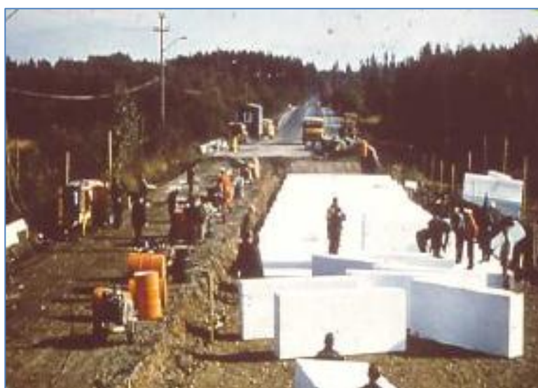
Figur 2.2 Den første EPS-fyllingen tar form på rv. 159 sør for Lillestrøm (Ref. 18) .
