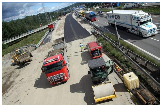
Figur 7.3 Fra åtte til fire felt under byggeperioden (H. Skjebstad, 2011).
