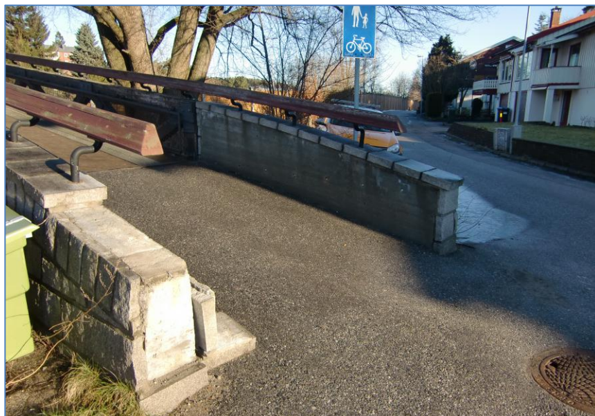
Figur 10.13 Østre fundament på Høiendal G/S (Hermansen, 2012).
