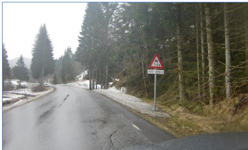
Figur 11.10 Nord for myrbroen på fv.610. Skiltet varsler om glattere forhold over broen (S. Hermansen, 2012).
