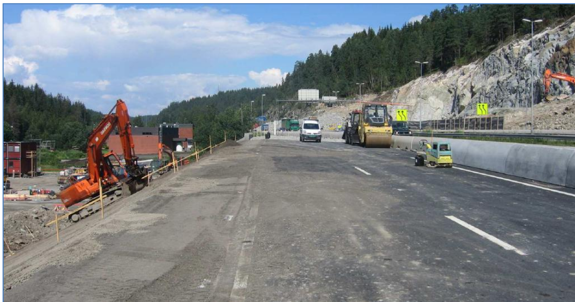
Figur 4.9 Ferdig med asfaltering, skråningene blir jevnet ut med gravemaskin (Ref. 20).
