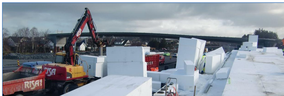
Figur 9.2 Lensmannsbroen i over Solasplitten med ramper av EPS (S. Hermansen, 2012).
