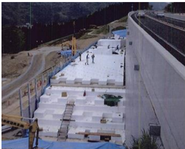
Figur 6.1 Yamagata Expressway, bilde fra byggetiden (Ref.34).
