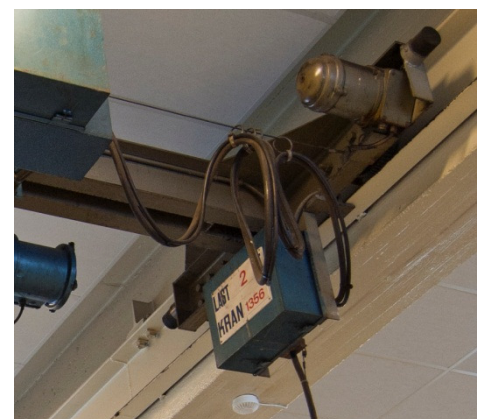
Figur 7: Bilde av den eksisterende kranbanen.
