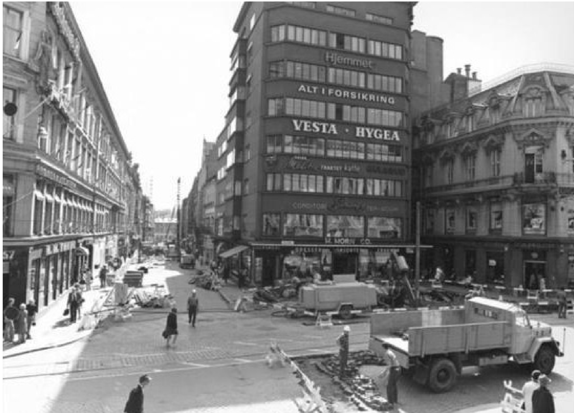
Bilde 3 : Arbeider med Sentrum stasjon, Egertorget, 1976, Ukjent
