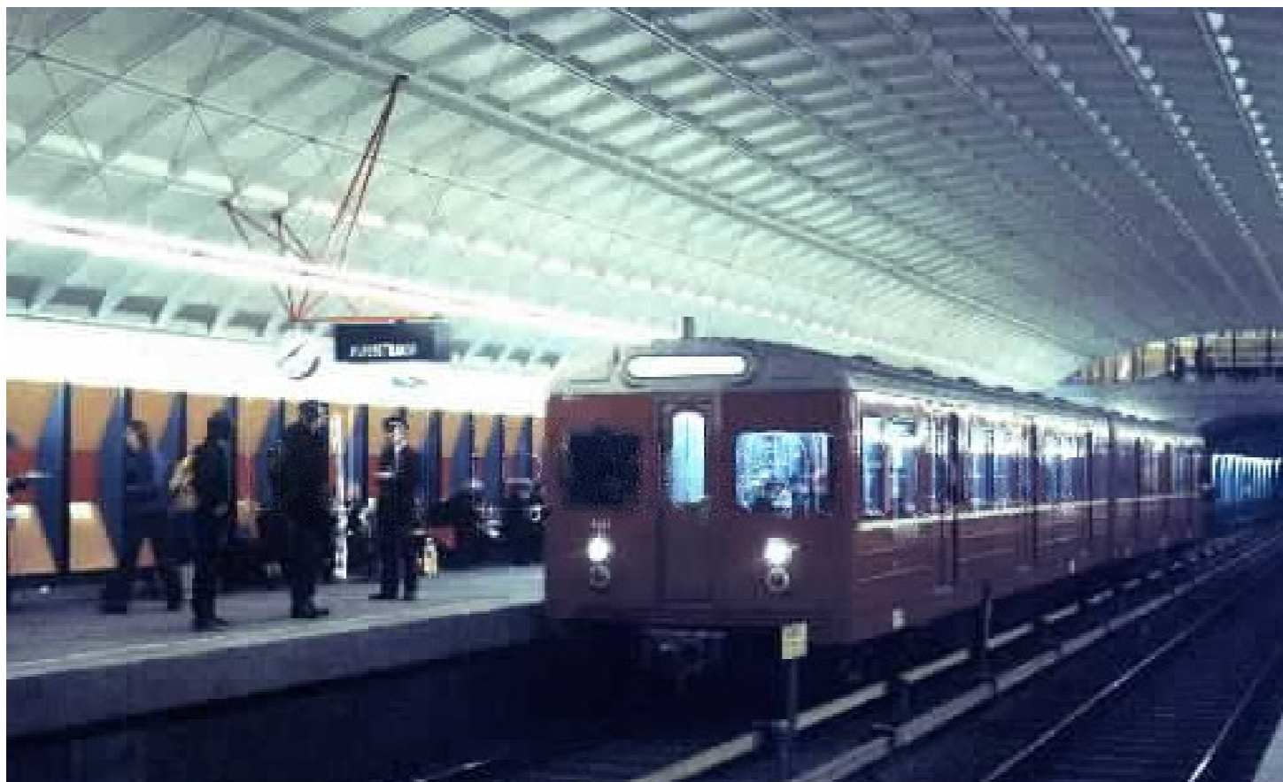
Bilde 54 : Den midtre stasjonshallen, med den originale himlingen, 1977, Bjørn Sigurdson
