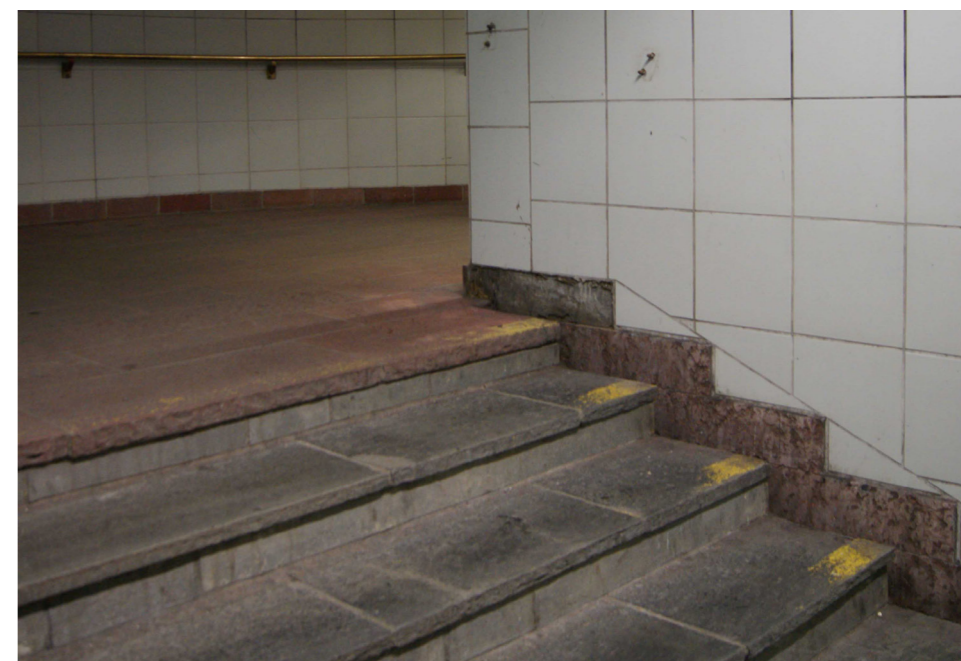
Bilde 21 : Slitne trappetrinn og fliser - merkingen er slitt bort, Akersgata. Håkon Rør Ellingsen
