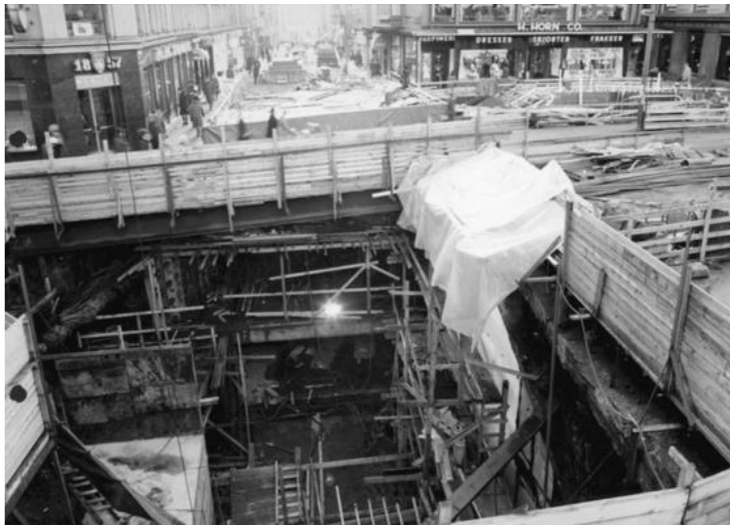
Bilde 2 : Konstruksjon av Sentrum stasjon, Egertorget, 1976, Ukjent
