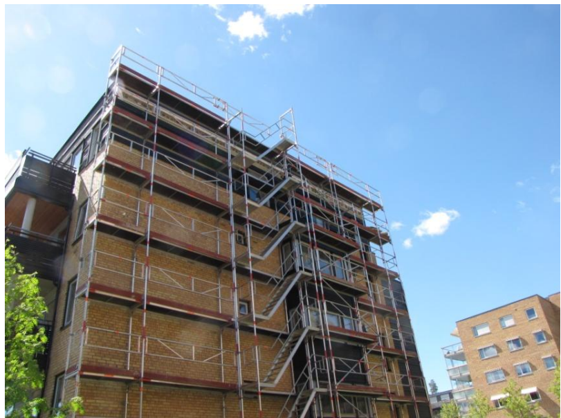
Figur 3.7: Stillas satt opp på nytt ved utvendige utbedringer
