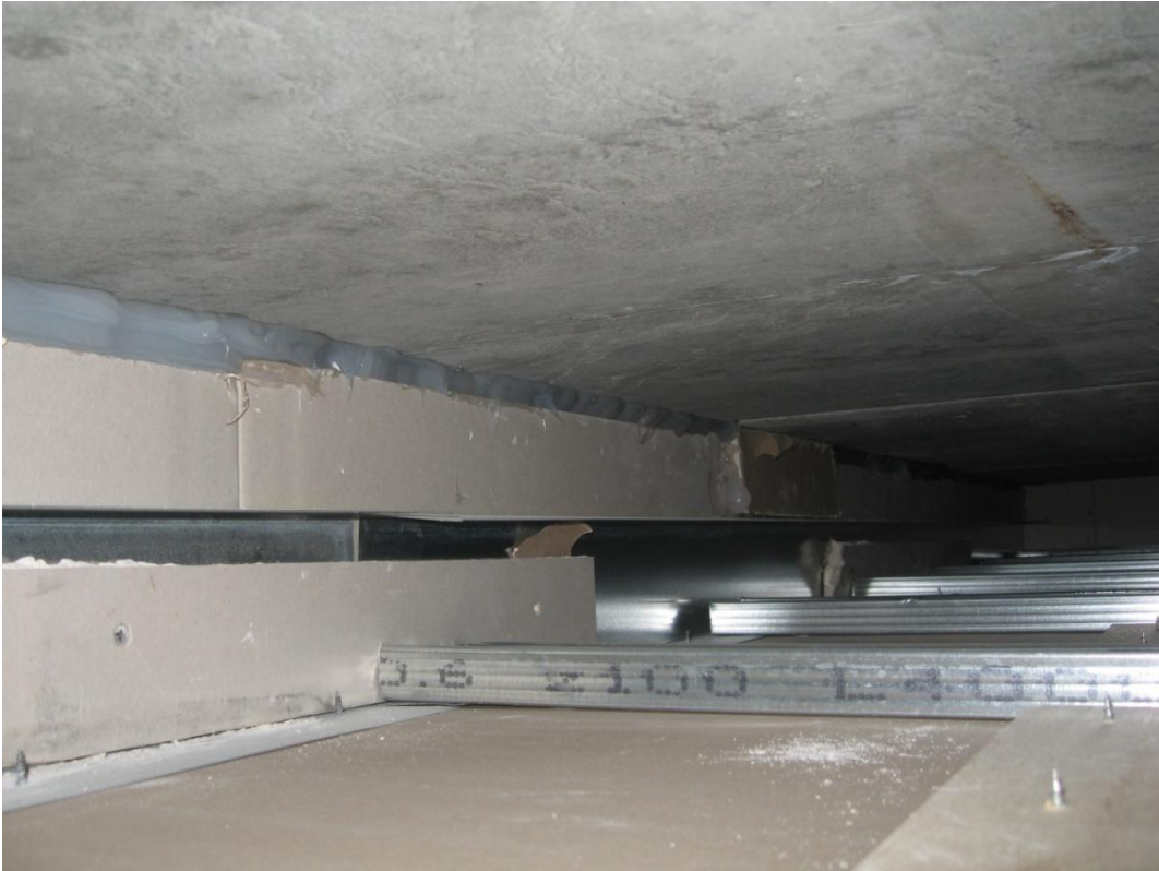
Figur 3.10: Bildet viser viser tilsvarende detalj som i figur 3.9 etter tetting. Her er det fuget i overgang dampsperre/hulldekke.
