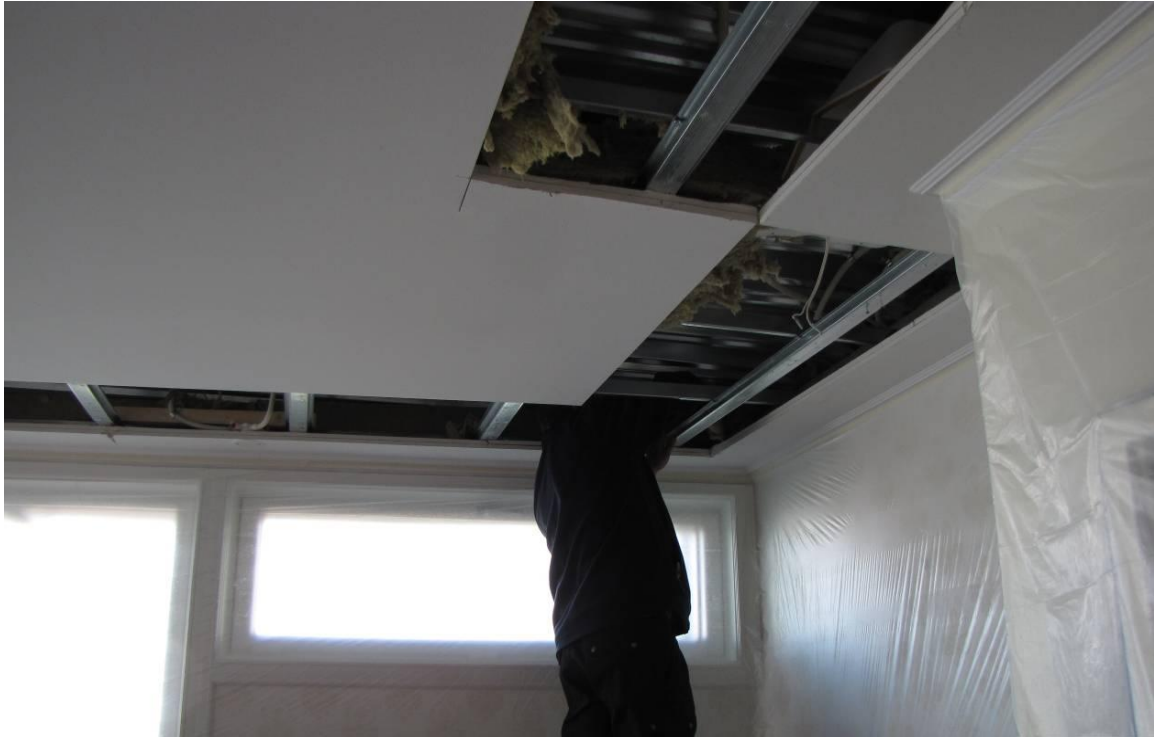
Figur 3.1: Åpning av nedsenket himling i store deler av leilighetene.
