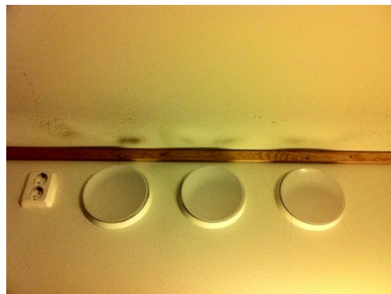
Figur 2.10: Støv- og partikkelansamling ved friskluftventil.
