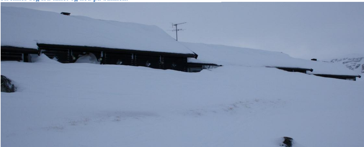
Figur 2: Her vises lofonn som strekker seg fra bakken og opp på taket.
