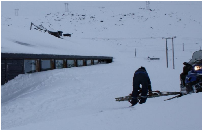
Figur 1: I dette bildet fra Finse 1222 meter over havet ses lefonn som strekker seg fra taket og ned på bakken.
