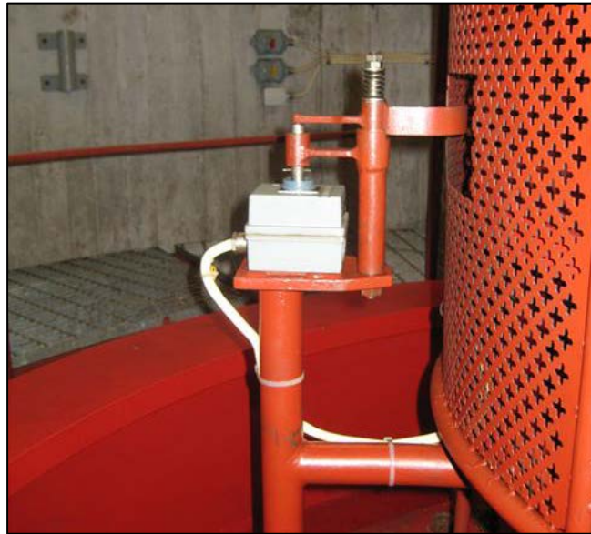
Figur 3-21: Mekanisk utløsermekanisme sett fra siden. Denne løsningen utløser et elektrisk signal [38] .
