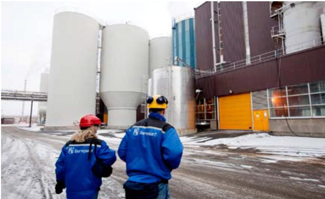
Figur 1.4.1: Bilde av utsiden av Borregaards blekeri.
