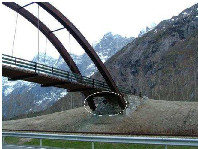
Figur 1.9 Ner-Hole bru, Møre og Romsdal. Utsnittet viser tverrbæreren og krysset av stål som forbinder buen/5/
