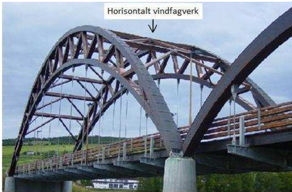
Figur 1.2 Trebru med limtrebuer avstivet med horisontalt vindfagverk/4/
