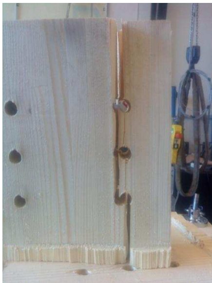
Figur F8. Etter undersøkelsene fikk trevirket oppsprekking langs dyblene.
