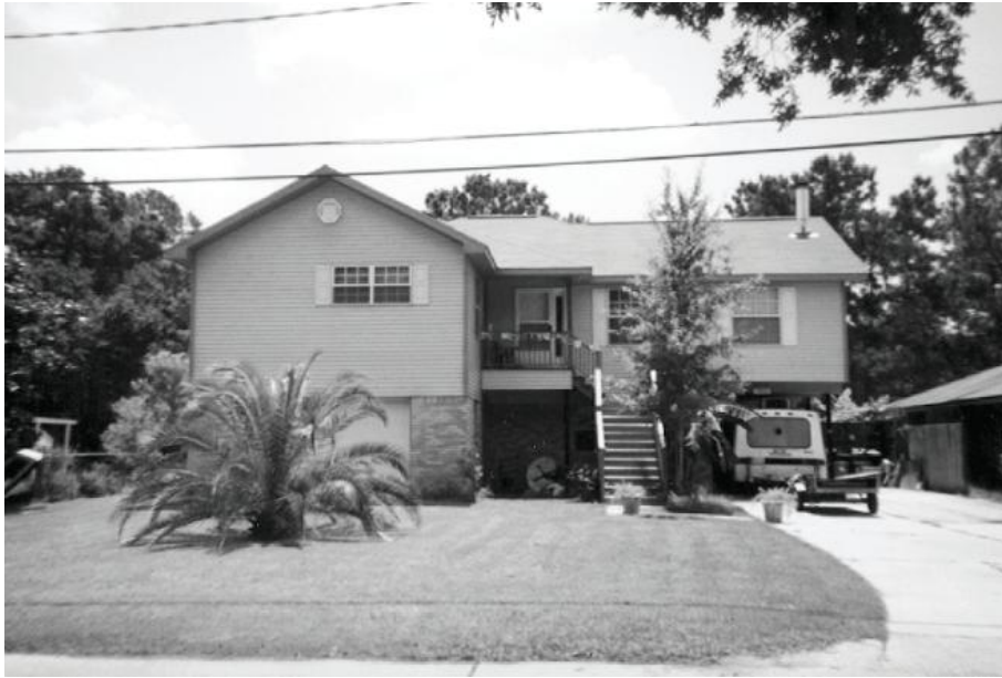
Figur 9: Bygning løftet på sammenhengende konstruksjon (FEMA 2009).
