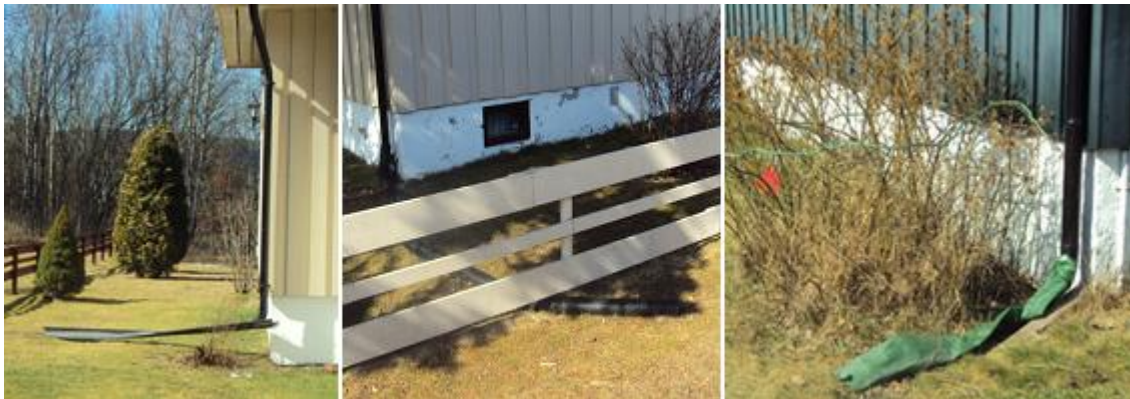
Bilde 3: Ulike løsninger for å lede takvannet til infiltrasjon på plen
