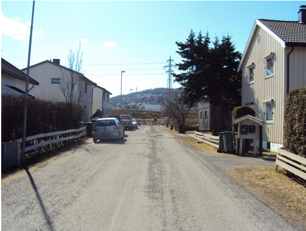
Bilde 1: Sjøgata sett fra den kryssende jernbanen. Her ser man vollen i enden og hvordan terrenget har sunket. Helningen fra vei ned mot hage kommer tydelig fram.
