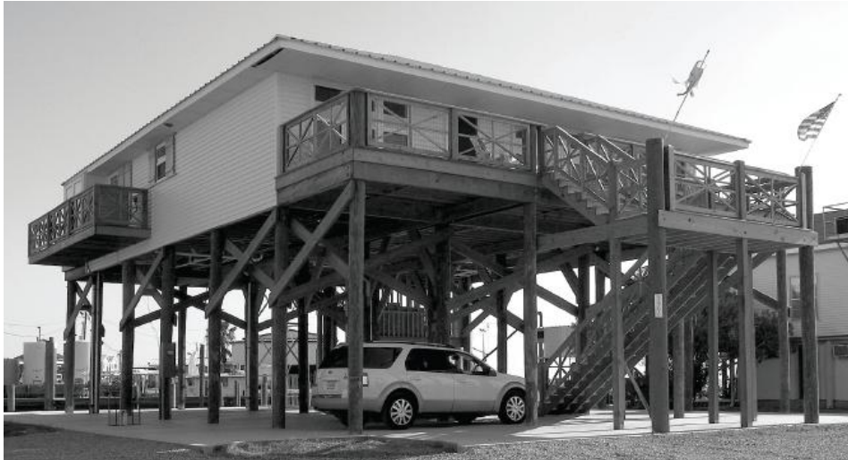
Figur 10: Bygning ved kysten som er løftet på peler for å tåle mer (FEMA 2009).
