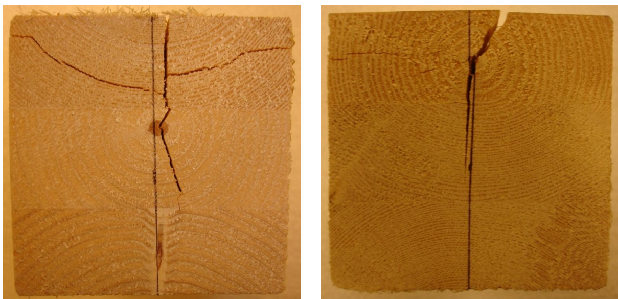
Figur 37 Kolvsprekk i svill B14 (lengde 225 mm).
