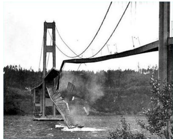
Figur 14; a) Tacoma Bridge før kollapsen sett fra undersiden [14], b) Tacoma Bridge etter kollapsen sett fra undersiden [15]
