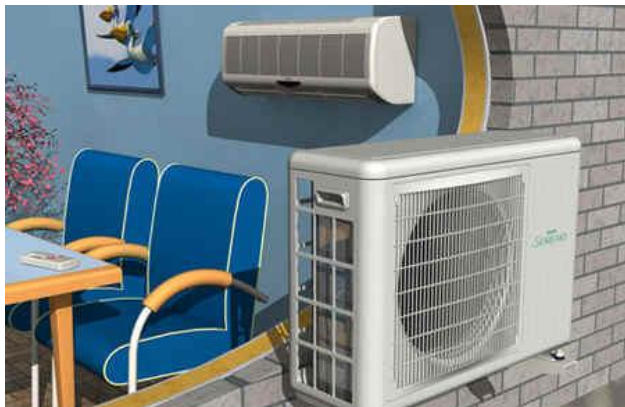
Figur 14. Illustrasjon av en montert luft/luft varmepumpe med utedel og inndel
