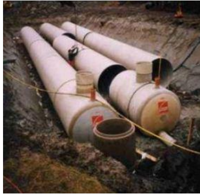
Figur 35: Figuren viser legging av rørmagasin. (Lindholm 2010b)
