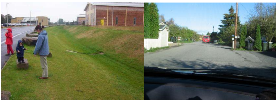
Figur 33: Illustrasjon på forskjellig bruk av veigrøft. Grøft til venstre vil gi fordrøyning og infiltrasjon av overvann. Grøft til høyre er bilde tatt i Oredalsveien i Veumdalen, med asfalterte grøfter på begge sider av veien. En slik løsning vil bidra til rask avrenning og hindre infiltrasjon til grunn. (Lindholm 2010b; Norconsult 2007)
