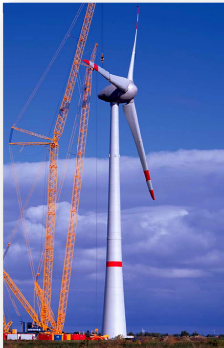
Figur 1: Verdens største turbintårn Enercon E-126 med en tårnhøyde på 135 m (Thomas 2008)
