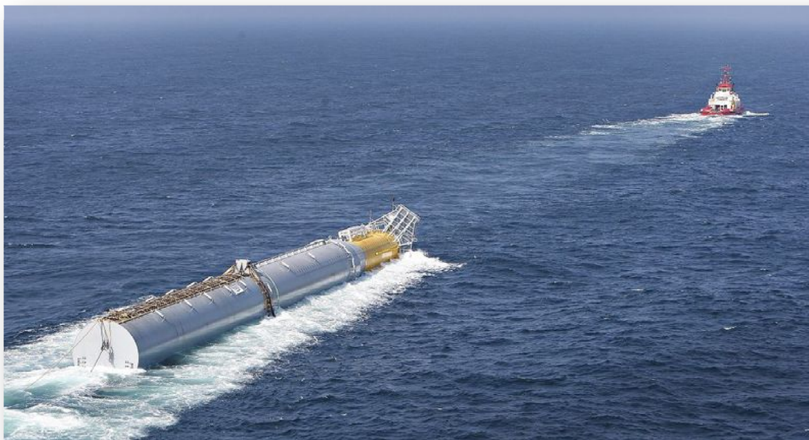
Figur 56: Tauing av flyteren til Hywind 2,3 MW pilotturbin (Ingemundsen 2009)
