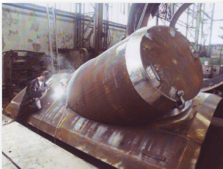
Figur 189: Sveising av 37mm rør til 90mm rør (PICKHAN Group 2008)
