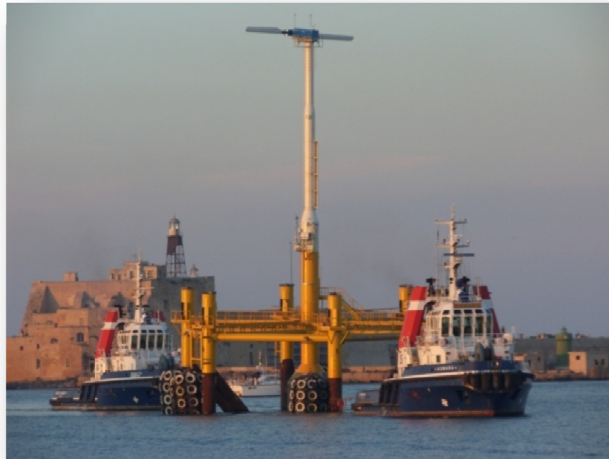
Figur 29: Tauing av verdens første flytende offshore demonstrasjonsturbin Blue H på 80 kW (Blue H Technologies BV 2007)
