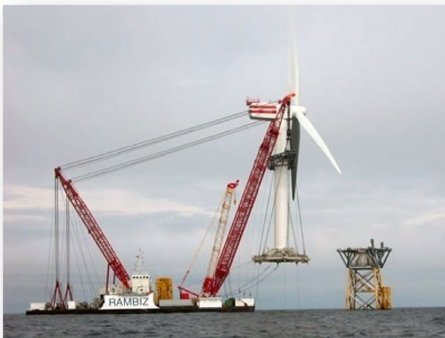
Figur 39: Montering av komplett vindturbin med kranfartøyet Rambiz (Scaldis Salvage & Marine Contractors NV 2006)
