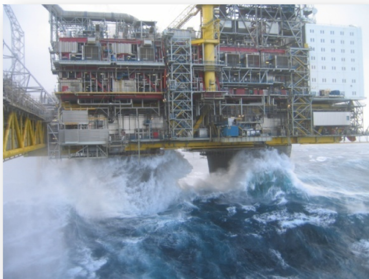
Figur 22: Offshore installasjoner må tåle store bølgepåkjenninger (Sloane 2008)
