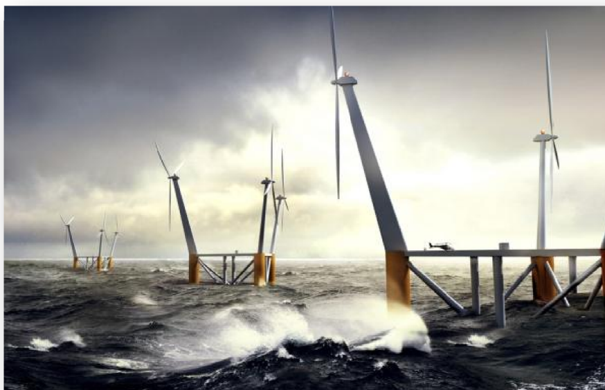
Figur 23: WindSea med tre vindturbiner per flyter vil ha en effekt på 10 MW (WindSea AS 2009)
