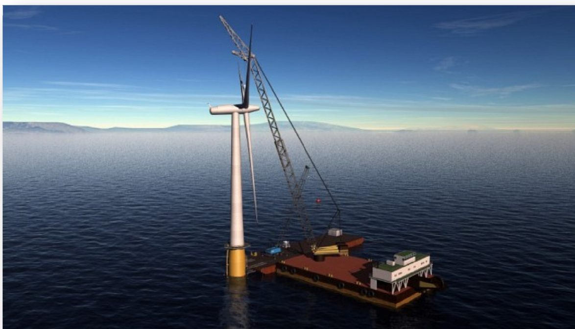
Figur 31: Rotoren monteres til nacellen med kranlekter (StatoilHydro 2009)
