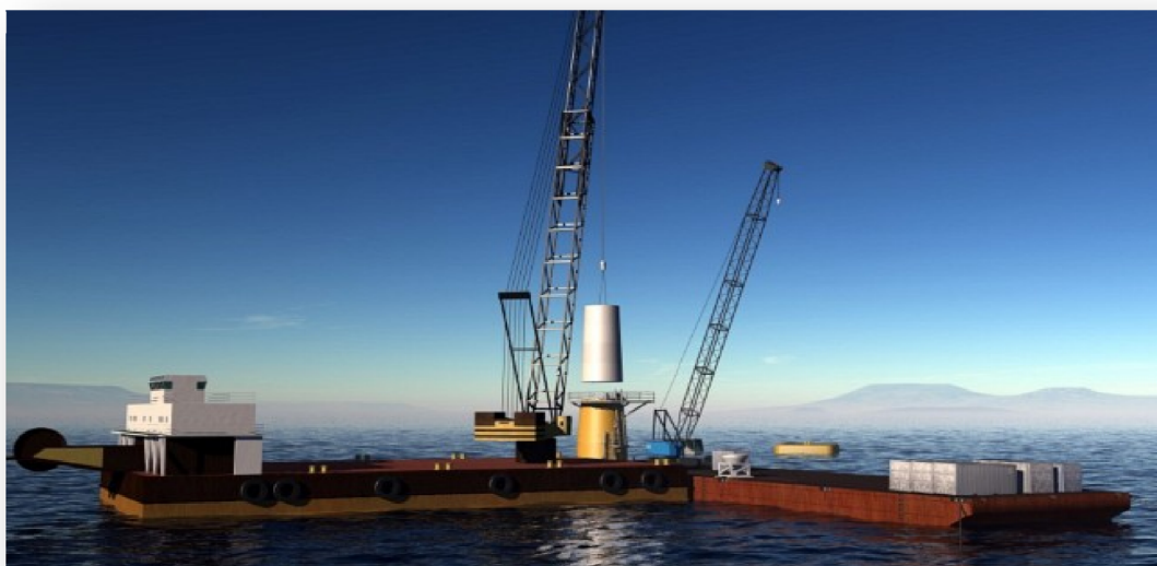
Figur 195: Montering av Hywind 2,3 MW pilotturbin med kraner i skjermede farvann (StatoilHydro 2009)
